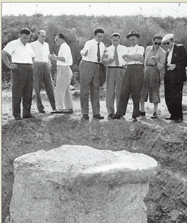
Obr. V. 41: Obnažený průkazný element první podzemní betonové stěny předvedený pro získání prvních kontraktů firmou I.C.O.S. v únoru 1950 u řeky Isonzo v severovýchodní Itálii
