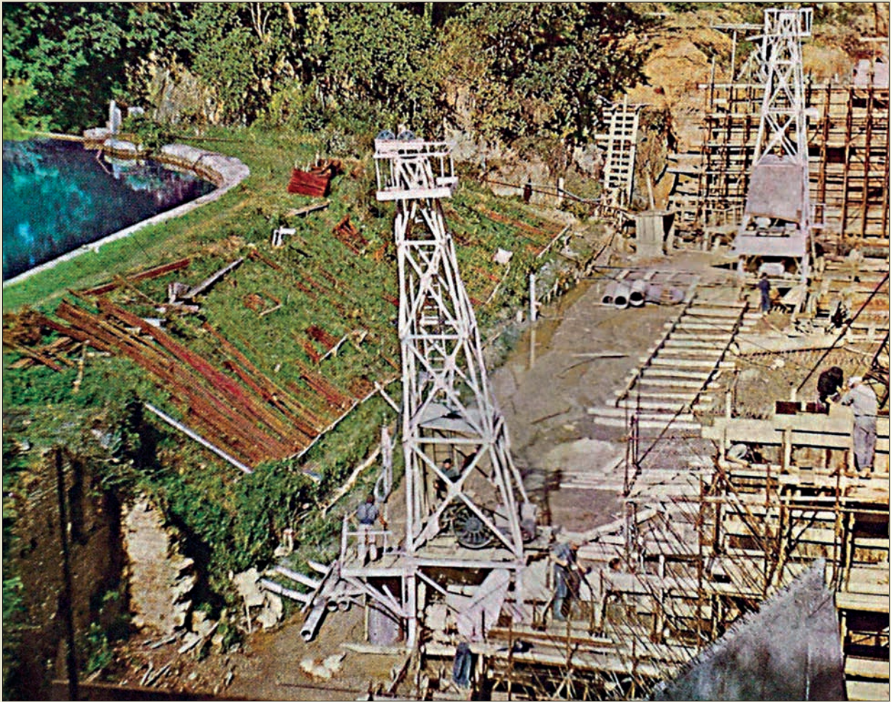
Obr. IV. 50: Vrtání pilot o průměru 60 cm typickou nárazovou soupravou s přímým bentonitovým výplachem na stavbě pilířové přehrady Beaufort ve Francii roku 1958 firmou I.C.O.S.
