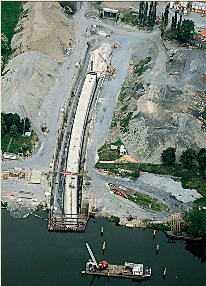
Obr. V. 11: Unikátní směrově i výškově zakřivený tubus o délce 168 m pro přechod metra pod Vltavou zbudovaný v jednom kuse v suchém doku. Dva takovéto tubusy byly postupně osazeny zatahováním a splavením v letech 2002 a 2003. (Metrostav/Zakládání staveb)
