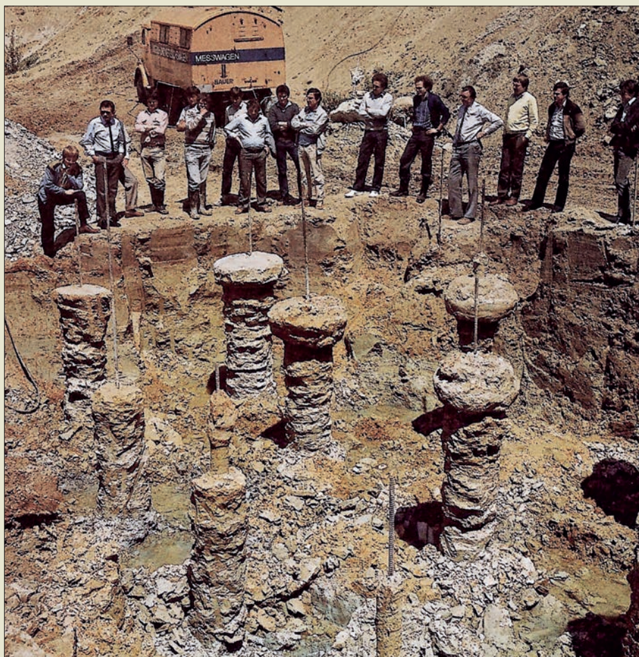
Obr. VI. 47: Zkušební pole s odkopanými sloupy pro zavádění technologických systémů tryskové injektáže firmy Bauer roku 1983
