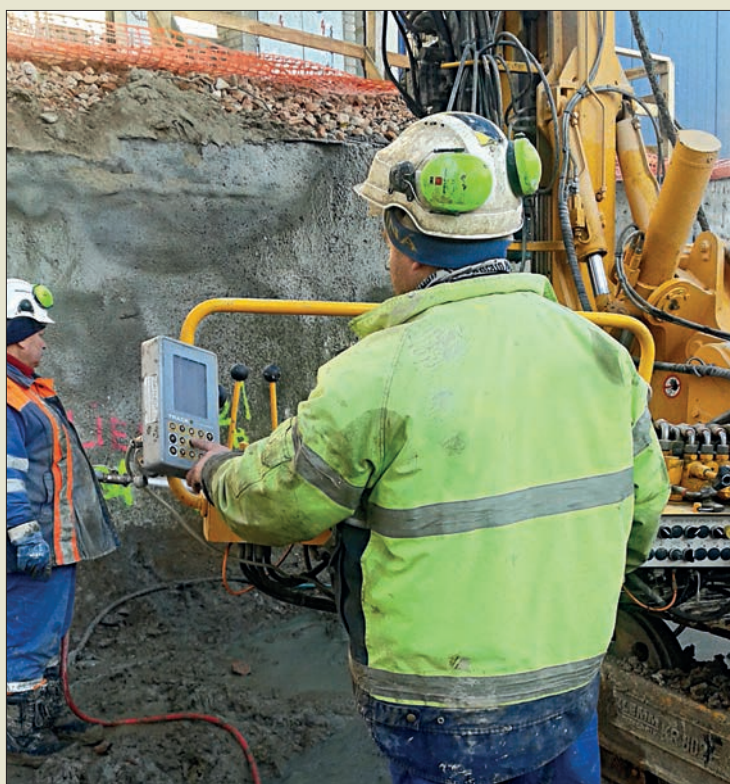
Obr. IV. 35: Počítačová kontrola procesu vrtání kotev přes displayové ovládání zařízení firmy Partner na stavbě speciálního zakládání v roce 2013
