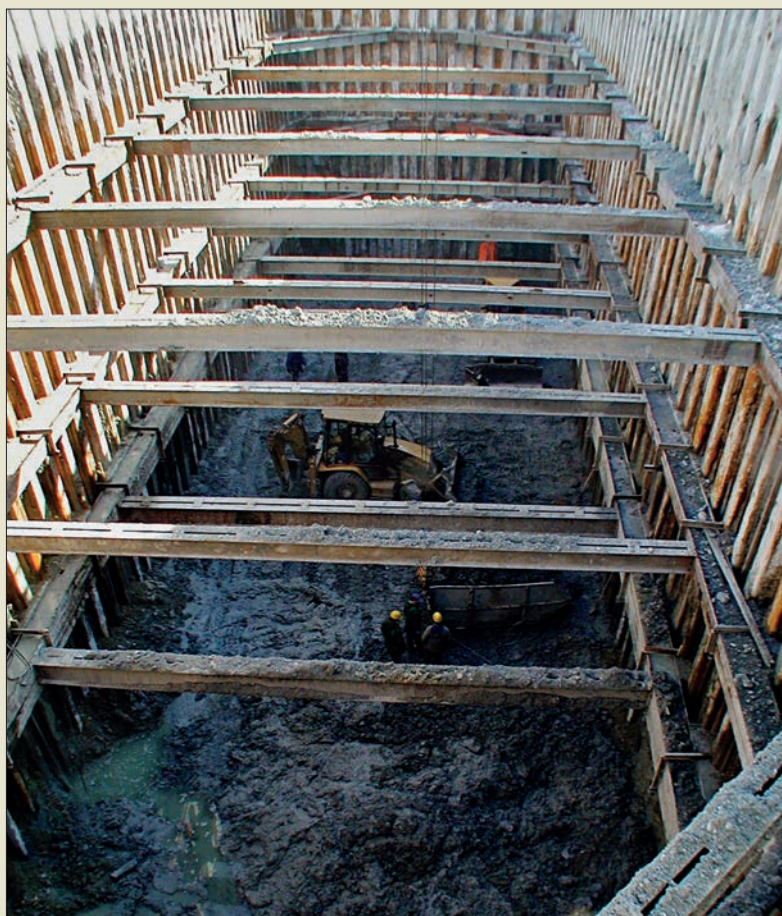
Obr. V. 33: Návodní jímka z ocelových výpažnic o průměru 1118 mm zavrtaných do 22 m v balvanitém prostředí při hloubce vody 8 m pro přístavbu vodní elektrárny ke stávající přehradě Derbendikan v Iráku roku 1982 (Zakládání staveb, a. s.)
