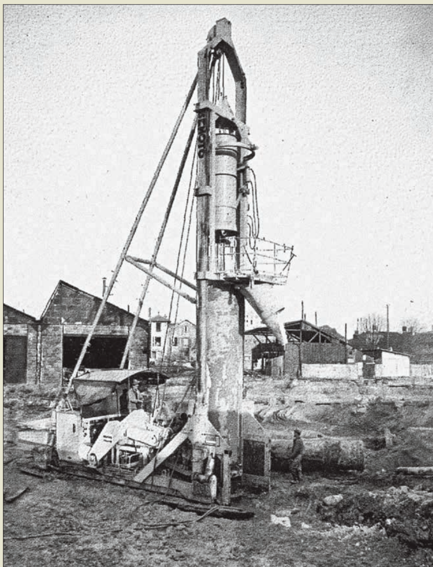
Obr. IV. 40: Drapáková souprava firmy Rodio s výpažnicemi zatlačovanými hydraulickým oscilátorem při práci v hrubých štěrcích roku 1979
