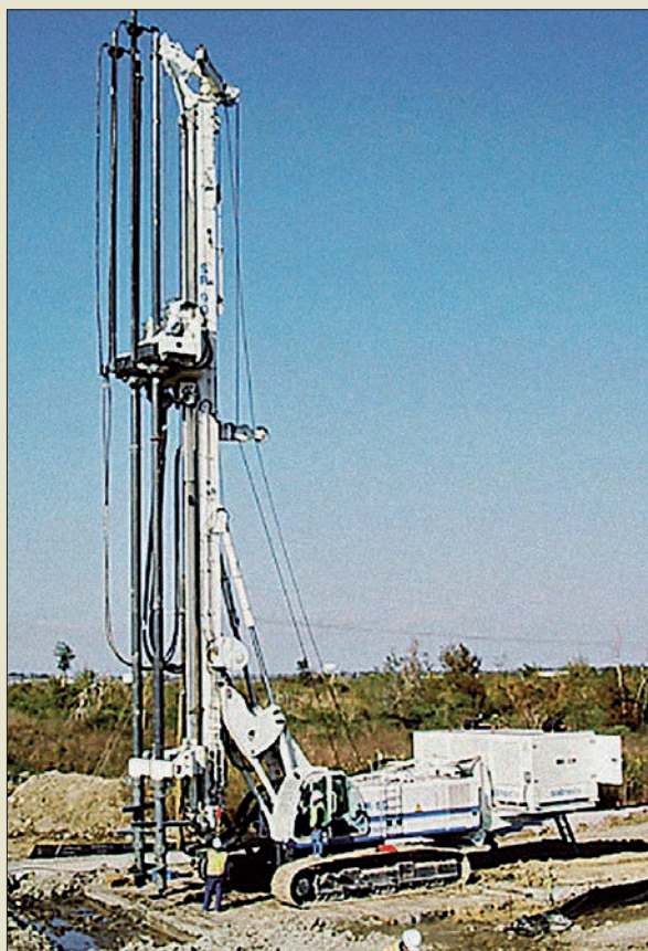
Obr. VI. 66: Souprava Soilmec SR-90 s dvojitým vrtákem systému Trevi-Jet při práci na zpevnění protipovodňové hráze v New Orleansu roku 2009. Prováděly se elementy ze sloupů o průměru 1,6 m do hloubky 24,4 m.
