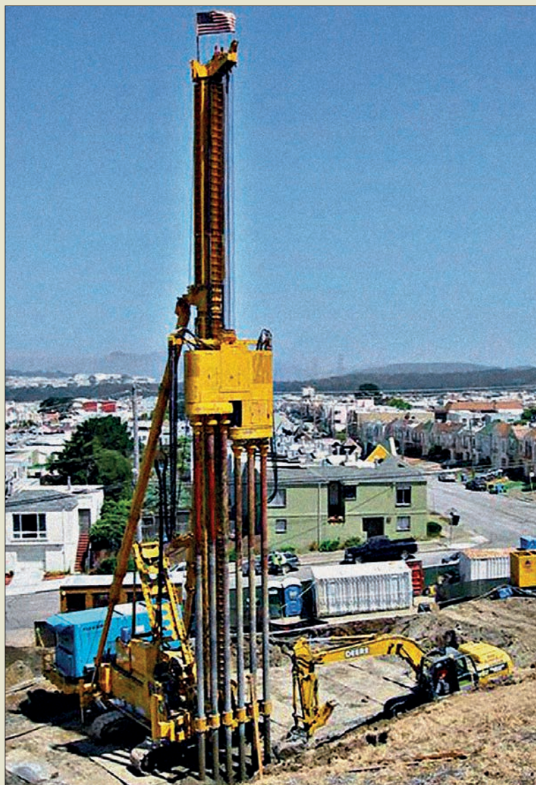
Obr. VI. 61: Šestidřívková vrtací a míchací baterie soupravy pro soil-mixing americké pobočky firmy Raito Kogyo na konci první dekády 21. století
