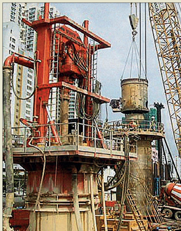
Obr. IV. 53: Vrtání velkopřůměrových pilot soupravou Wirth s reverzní cirkulací výplachu na stavbě metra v Hongkongu firmou Soletanche roku 1996
