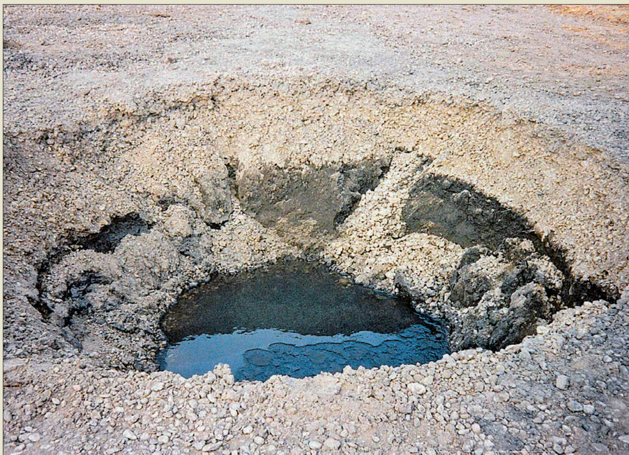
Obr. VI. 115: Vtisk do povrchu skládky Spolany Neratovice po prvním dynamickém rázu pěchu v místě nejvíce oslabené zóny základového prostředí s kalovými odpady
