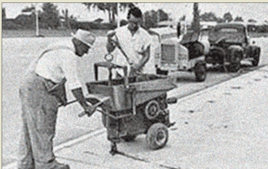
Obr. VI. 29: Oprava betonového chodníku pneumatickým zařízením Koehring-Mudjack s nožovým hnětačem směsi a pístovou pumpou v USA roku 1939
