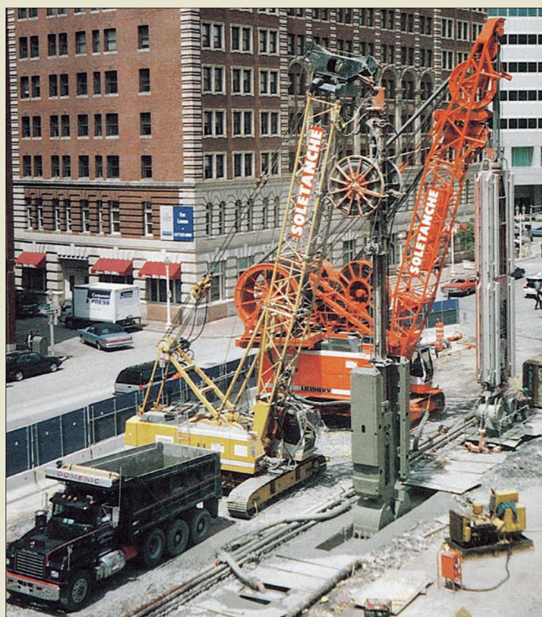
Obr. V. 55: Typická evropská sestava souprav hydraulického drapáku a hydrofrézy firmy Soletanche ze stavby hloubených tunelů centrální automobilové tepny v americkém Bostonu roku 1996
