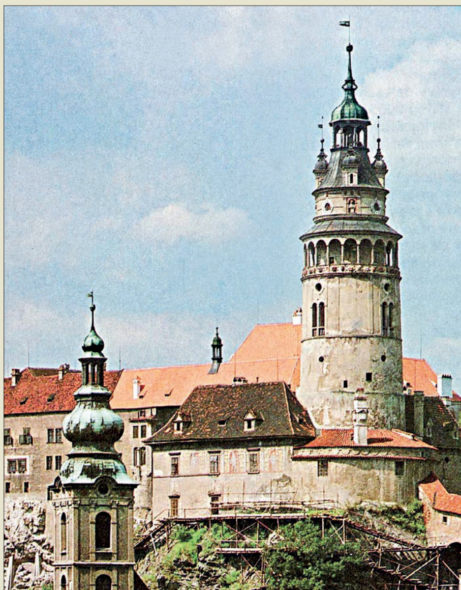
Obr. VI. 13: Zajištění skalního svahu pod zámek Český Krumlov cementovou injektáží a kotvenými železobetonovými žebry (Zakládání staveb, a. s.)
