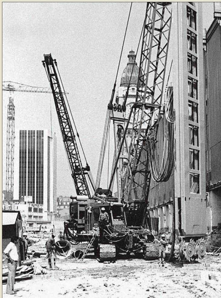
Obr. V. 53: První hydrofréza firmy Soletanche s těžkým bagrjeřábem na stavbě nádraží Gare de Lyon v Paříži roku 1974
