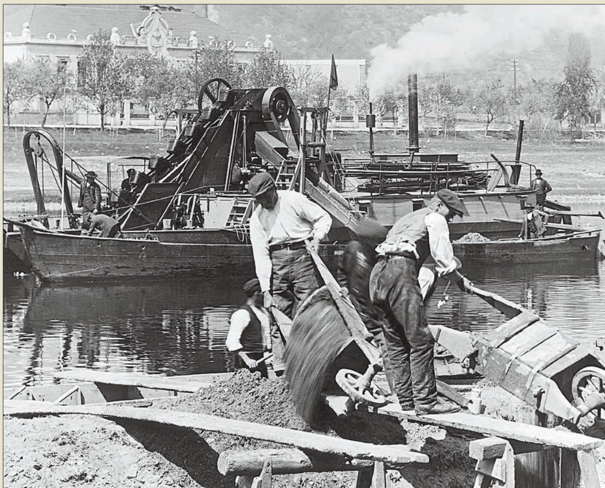
Obr. V. 7: Korečkový bagr č. 6 firmy Lanna v roce 1899 ještě s ručním odklizením výkopku na stavbě jezu v Troji (Z. Bauer)
