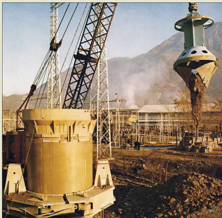
Obr. IV. 40: Drapáková souprava firmy Rodio s výpažnicemi zatlačovanými hydraulickým oscilátorem při práci v hrubých štěrcích roku 1979
