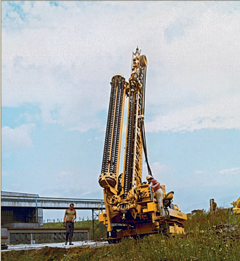
Obr. IV. 33: Vrtání těžkou zásobníkovou soupravou Hausherr HBM 150 s dlouhým průběžným šnekovým vrtákem o průměru 140 mm do hloubky 120 m v jílech hnědouhelného revíru pro sanaci dolu na přeložce trati ČSD Ústí nad Labem – Teplice v roce 1979 (Zakládání staveb, a. s.)
