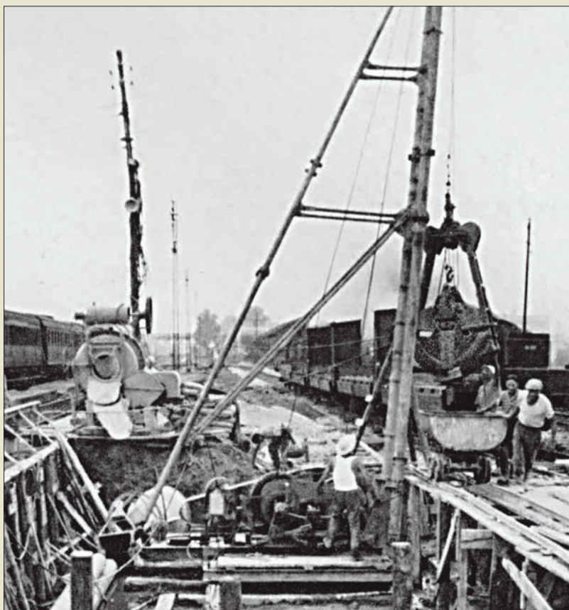
Obr. V. 48: Původní model lehkého dvoulanového drapáku s trojnožkou na stavbě firmy I.C.O.S. pro podchod na benátském nádraží Mestre v Itálii roku 1963 – je zřejmá obtížná ruční manipulace při vyprazdňování drapáku do vozíku.
