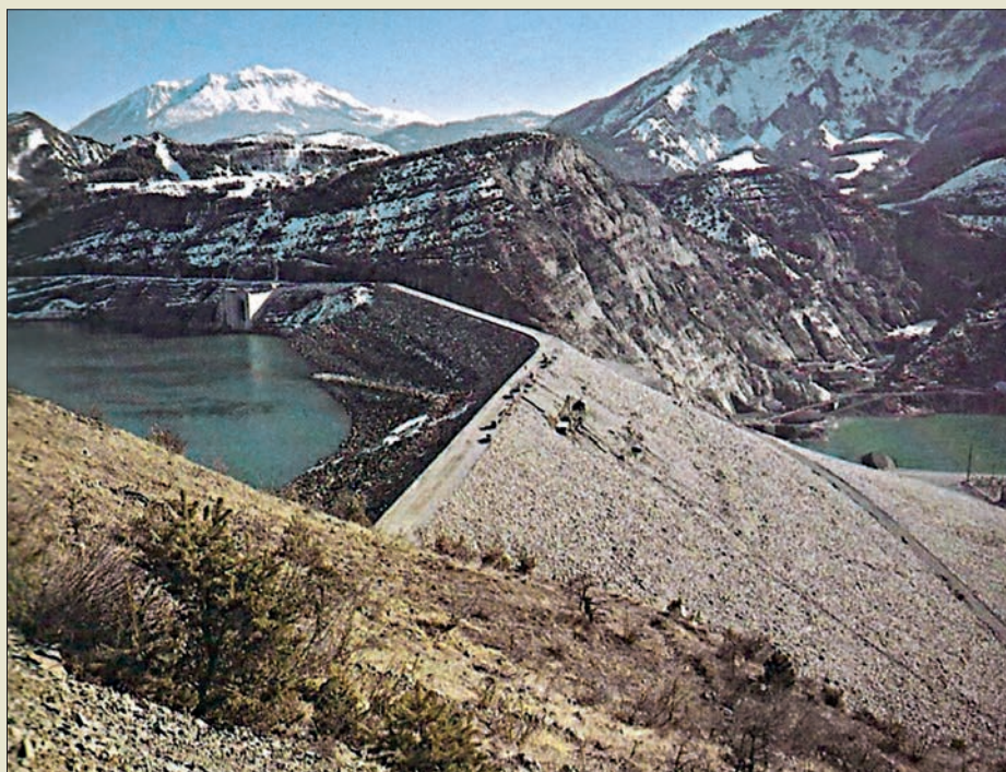
Obr. VI. 16: Přehrada Serre- -Ponçon ve Francii, nejvýznamnější stavba v nástupu injektáží jemnozrnných zemin manžetovými trubkami, dokončená roku 1961
