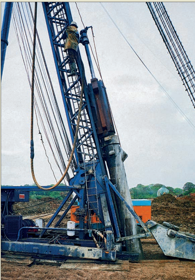
Obr. III. 11: Souprava pro výrobu pilot typu Vibropile britské firmy PCL z roku 1982
