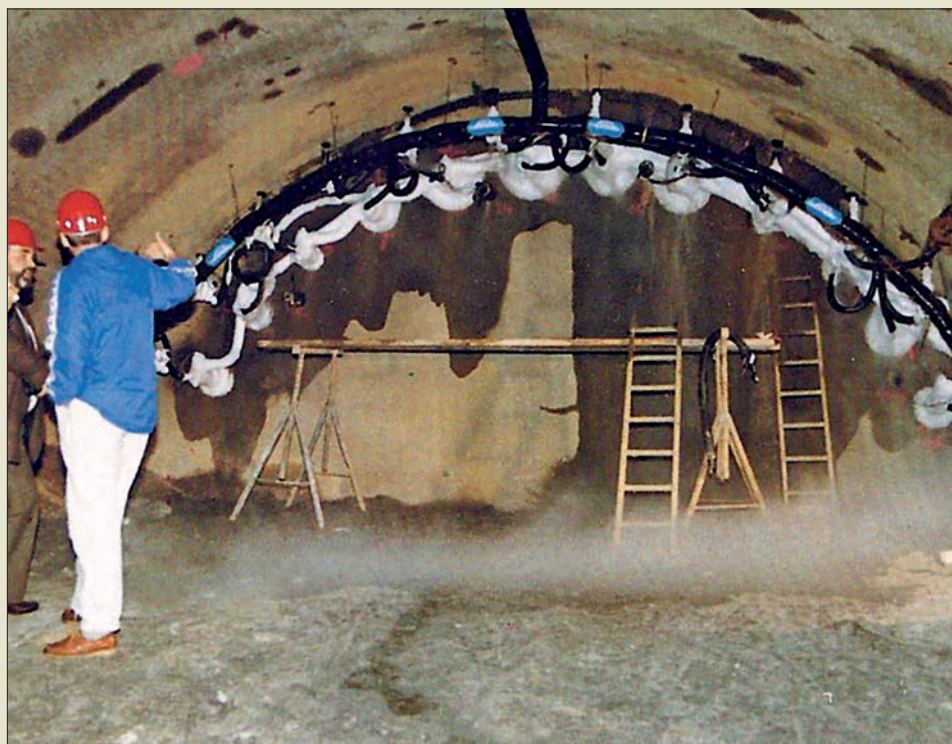
Obr. VI. 123: Ochranná klenba zeminy zmrazené z 12 vrtů vyplněných kapalným dusíkem, zhotovená firmou Soletanche pro ražbu tunelu linky U3 vídeňského metra roku 1987
