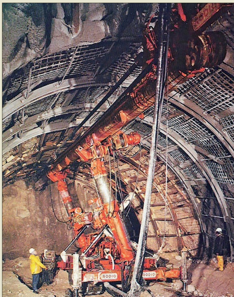
Obr. VI. 51: Zajištění nadloží pro ražbu tunelu Campiolo pomocí „deštníků“ ze 40 subhorizontálních sloupů jednofázové tryskové injektáže o délce 13 m firmou Rodio roku 1983
