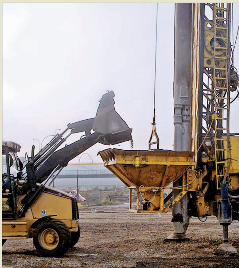
Obr. VI. 72: Plnění skipu suchou betonovou směsí pro zhotovení betonových sloupových inkluzí technologií průchozího ponorného vibrátoru na pražské stavbě firmy Keller roku 2002
