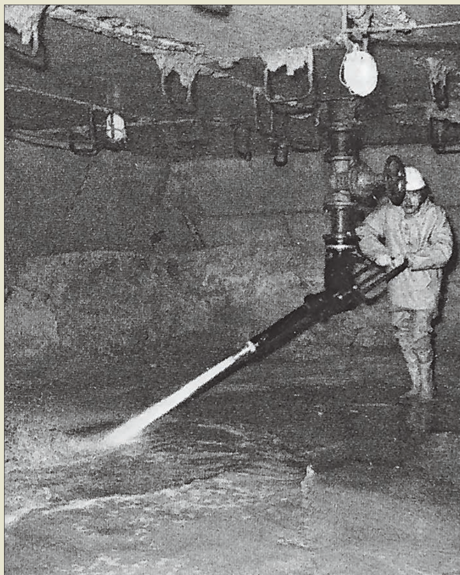
Obr. VI. 40: Hydraulické rozpojování jemnozrnných zemin uvnitř přetlakového kesonu v Nizozemsku v padesátých letech 20. století
