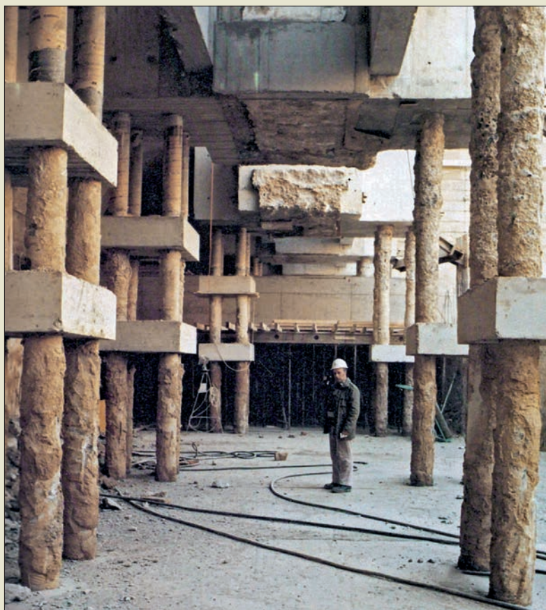
Obr. VI. 85: Vrtané mikropiloty většího průměru firmy StumpBOHR, středově vyztužené silnostěnnou injekční manžetovou trubicí o průměru 100 mm pro injektáž kořene k podchycení budov bárkami na stavbě stanice vídeňského metra Messeplatz roku 1981
