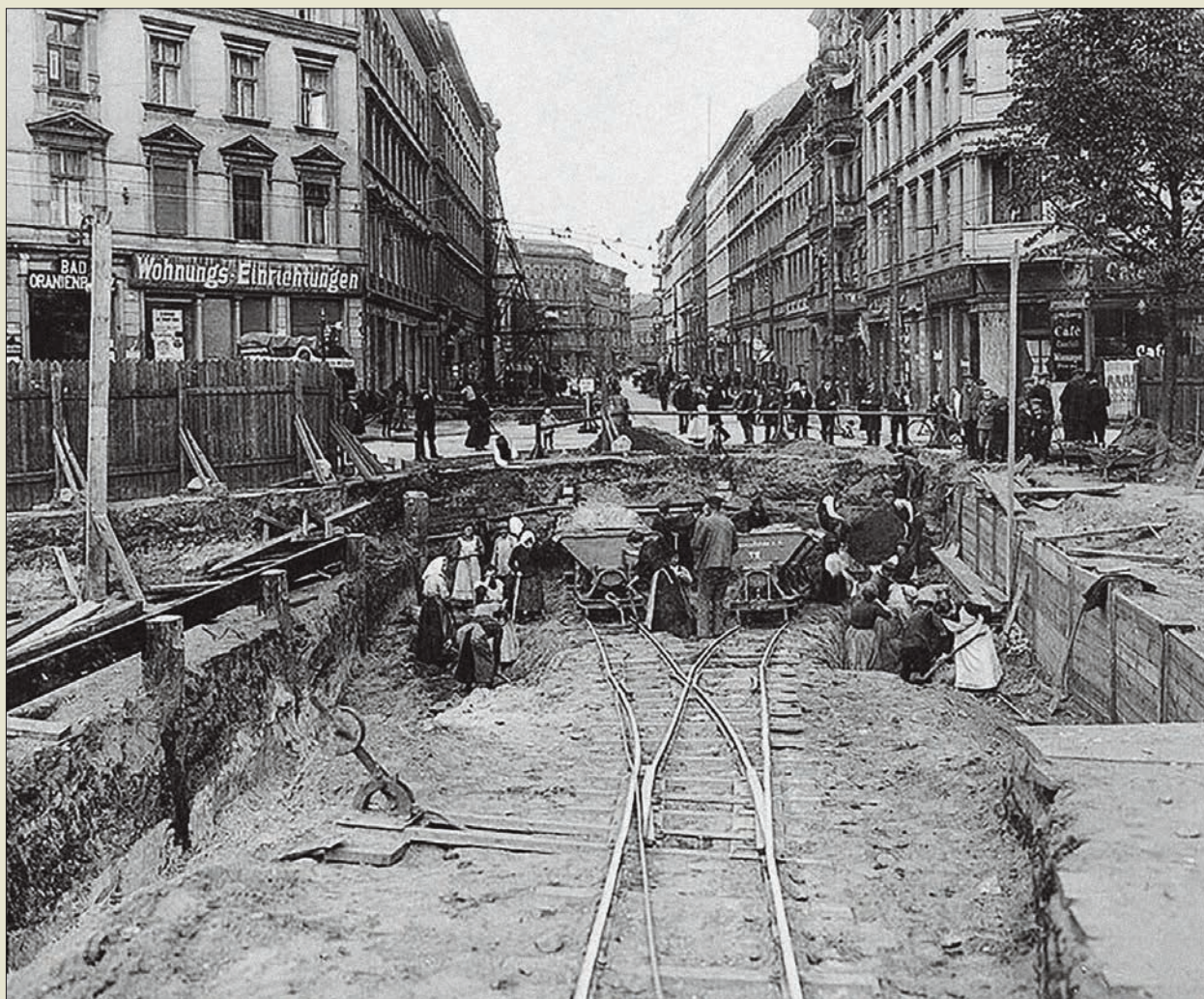
Obr. V. 36: Výkop jámy zajištěné raženým záporovým pažením pro hloubený tunel berlínské U-Bahn na Dresdener Strasse roku 1907
