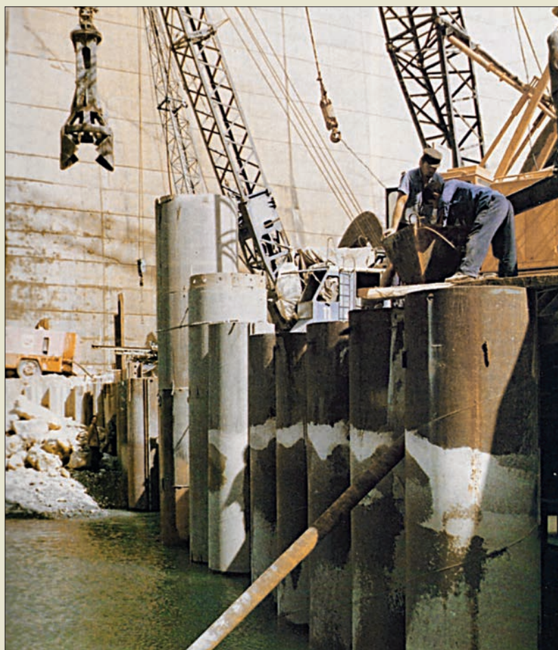
Obr. V. 33: Návodní jímka z ocelových výpažnic o průměru 1118 mm zavrtaných do 22 m v balvanitém prostředí při hloubce vody 8 m pro přístavbu vodní elektrárny ke stávající přehradě Derbendikan v Iráku roku 1982 (Zakládání staveb, a. s.)
