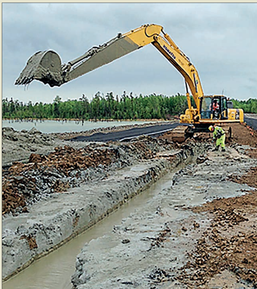
Obr. V. 72: Typický způsob provádění kontinuální těsnicí clony ze samotvrdnoucí suspenze s užitím konvenčního rypadla s podkopovou lžící na dlouhém výložníku na počátku 20. století
