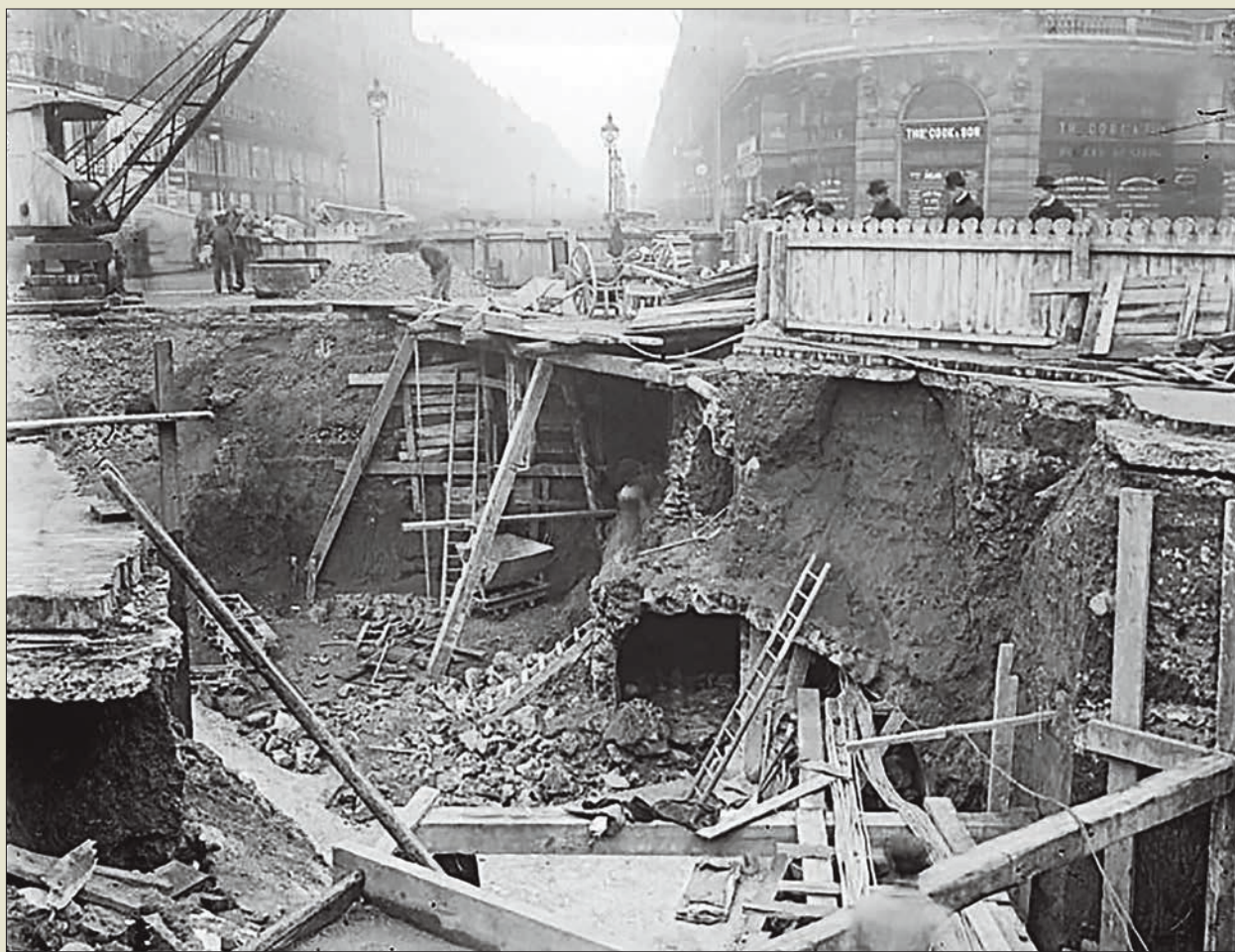
Obr. V. 34: Částečně roubená a pažená jáma hloubená pomocí parního jeřábu v poměrně stabilní zemině pro stanici pařížského metra v roce 1899
