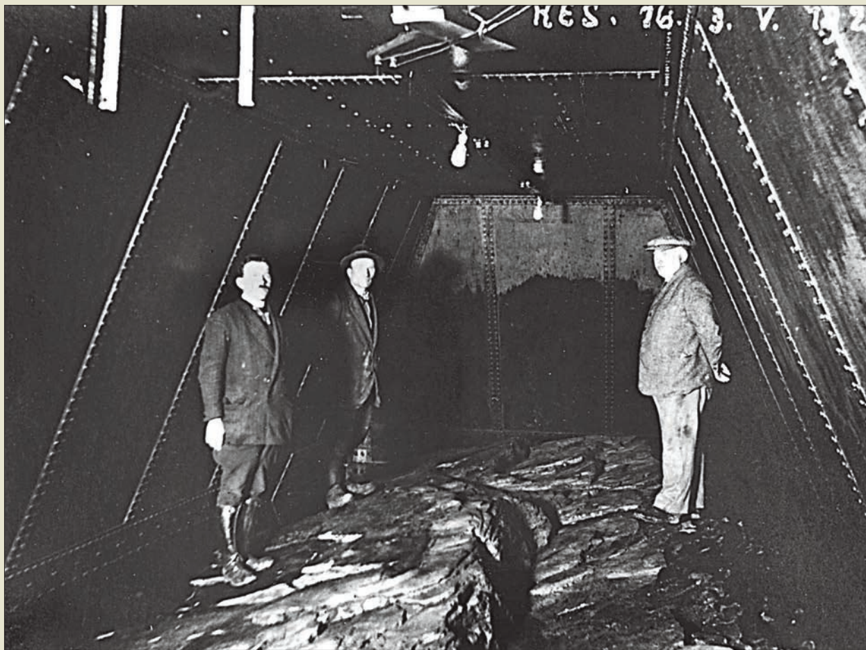
Obr. V. 20: Vnitřek nýtovaného ocelového pneumatického kesonu č. 16 na stavbě plavební komory Štěrkov, prováděné firmou Lanna v roce 1927 (Z. Bauer)
