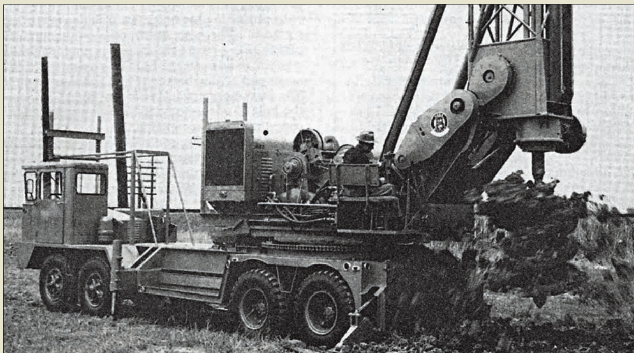
Obr. IV. 43: Vrtná souprava americké firmy McKinney Drilling na automobilovém podvozku roku 1960
