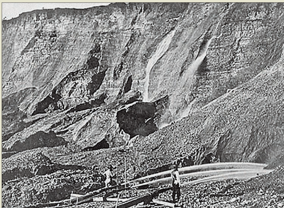
Obr. VI. 39: Hydraulické rozpojování hornin tlakovým paprskem vody z hydromonitorů v kalifornském dolu Dutch Flat v šedesátých letech 19. století
