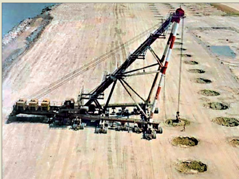
Obr. VI. 113: Ménardova souprava pro dynamické hutnění/konsolidaci s pěchem o tíže 170 t a výšce pádu 22 m na stavbě dráhy letiště v Nice prováděné roku 1978 firmou Ménard
