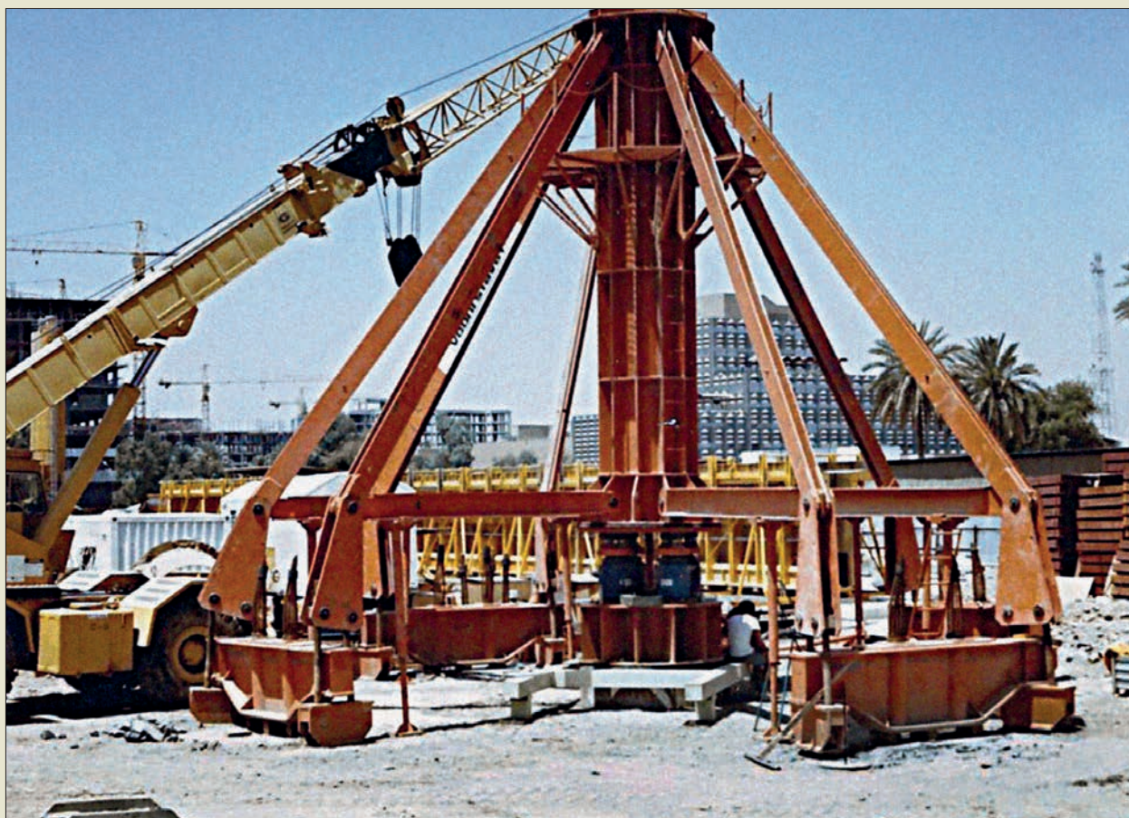
Obr. IV. 48: Zařízení pro zatěžovací zkoušku piloty o kapacitě 25 000 kN na stavbě Sinak Bridge v iráckém Bagdádu roku 1983
