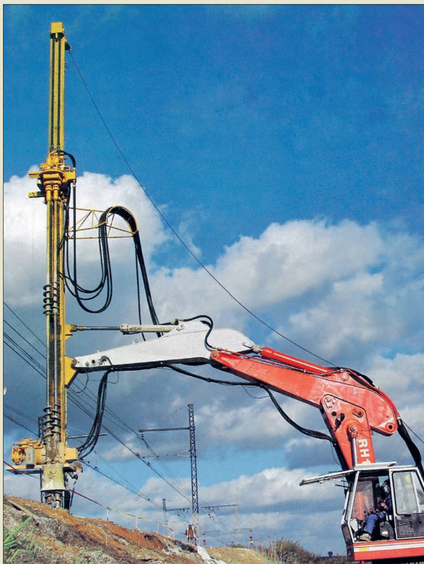
Obr. VI. 59: Souprava systému Colmix firmy Bachy s dvěma protiběžnými spirálovými vrtáky pro soil-mixing o výsledné tloušťce tělesa podle parametrů režimu od 410 do 875 mm, nasazená roku 1987 na sanaci náspu rychlodráhy TGV ve Francii
