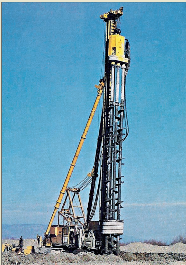
Obr. VI. 57: Dlouholetou praxí osvědčený typ soupravy pro SMW s trojitým paralelním vrtákem o průměru 86 cm a dosahem do hloubky 20 m; metoda japonské firmy Seiko na počátku osmdesátých let
