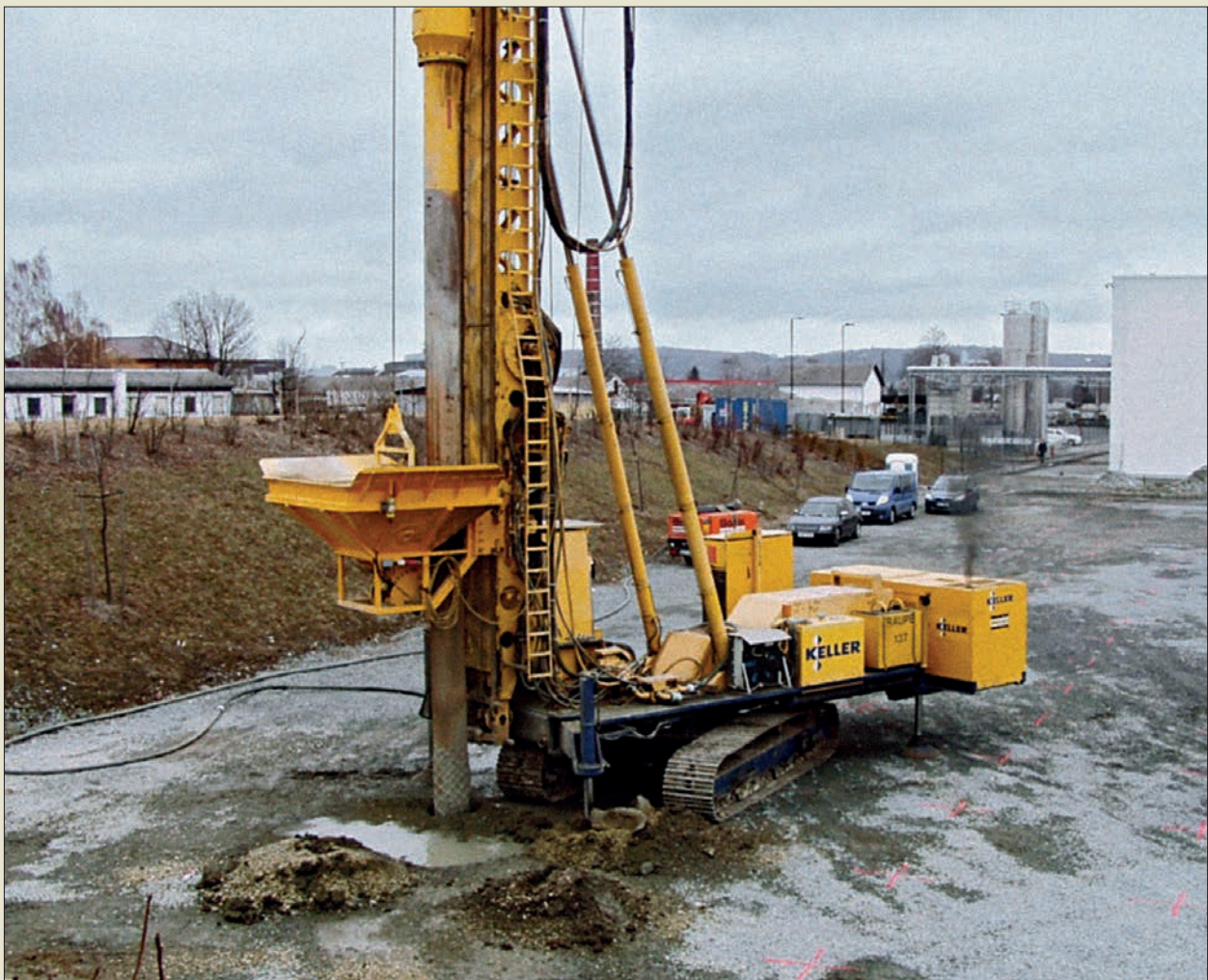
Obr. III. 15: Nasazení kompaktní soupravy Vibrocat s ponorným vibrátorem a vrchním dávkováním šterku na hrot vibrofloty pomocí skipu na stavbě firmy Keller v ČR
