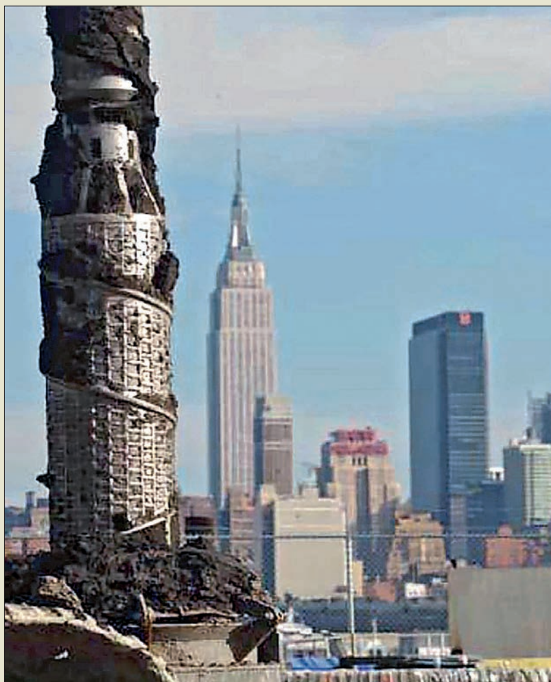
Obr. VI. 69: Speciální roztlačovací vrták technologického systému původní metody CMC použitý firmou Soletanche-Freyssinet/Ménard ve zvodnělých heterogenních násypch a měkkých organických jílech až do hloubky 30 m na stavbě rezidenčního komplexu v New Yorku roku 2004
