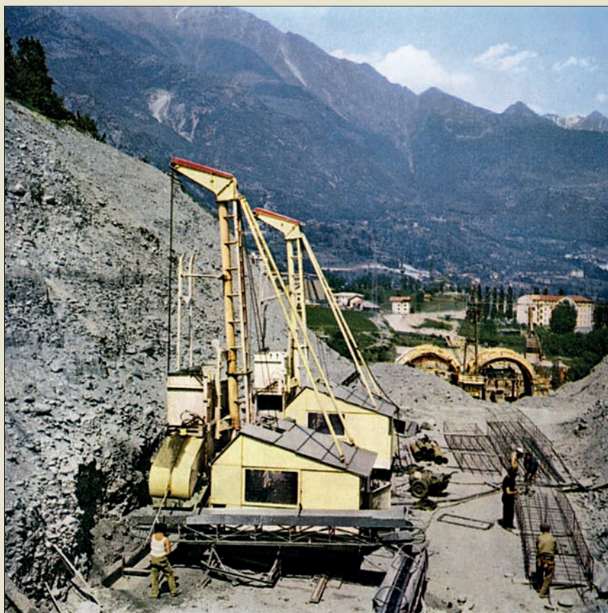
Obr. V. 49: Ukázka sestavy lehkých drapákových strojů pro podzemní stěny tloušťky 80 cm firmy I.C.O.S. na stavbě tunelu dálnice A5 u Chatillonu v severní Itálii v roce 1967 – zřetelné je složité řešení vyprazdňování drapáků do násypkových skříní a na pásové dopravníky.
