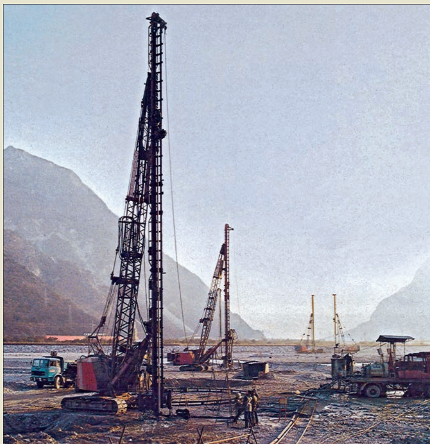
Obr. VI. 48: Zakládání pilířů nové železniční estakády Moggio Udine, probíhající údolní nivou řeky Felly, v jámkách vytvořených v kyprých náplavech s balvanů tryskovou injektáží italskou firmou Rodio roku 1983
