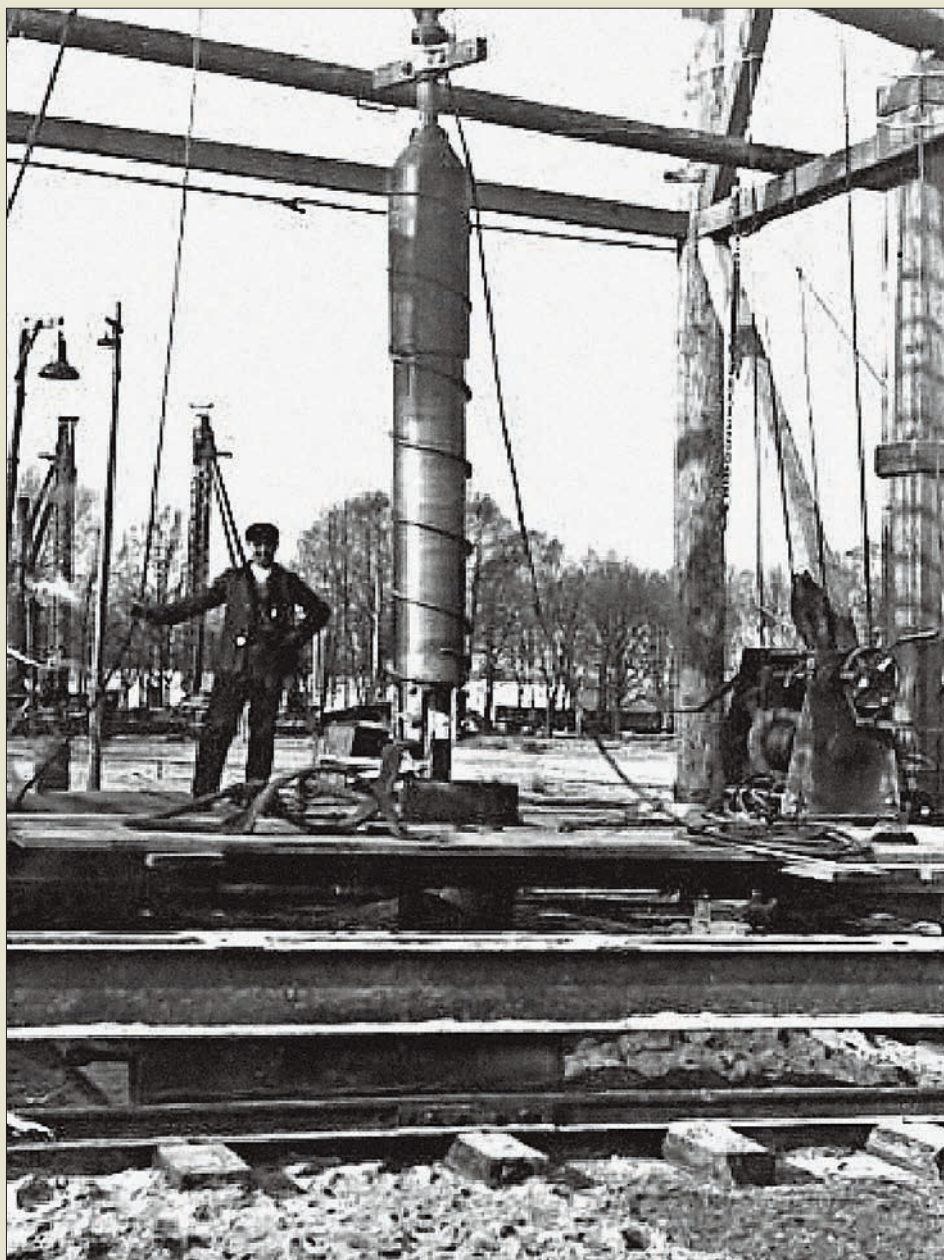
Obr. III. 14: První ponorný vibrátor z roku 1937 na stavbě firmy Keller
