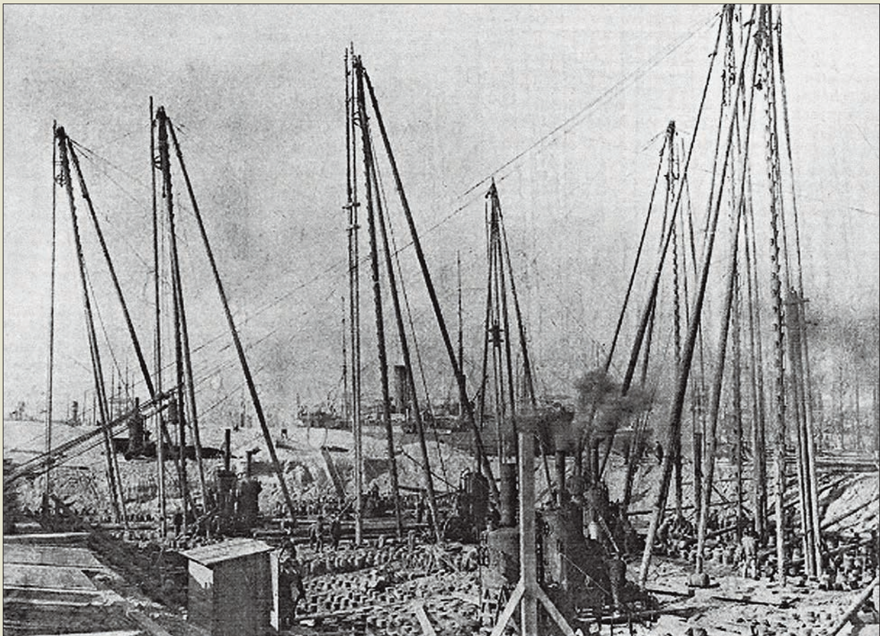
Obr. III. 19: Staveniště s beraněním dřevěných pilot mnoha beranidly v Rotterdamu roku 1921
