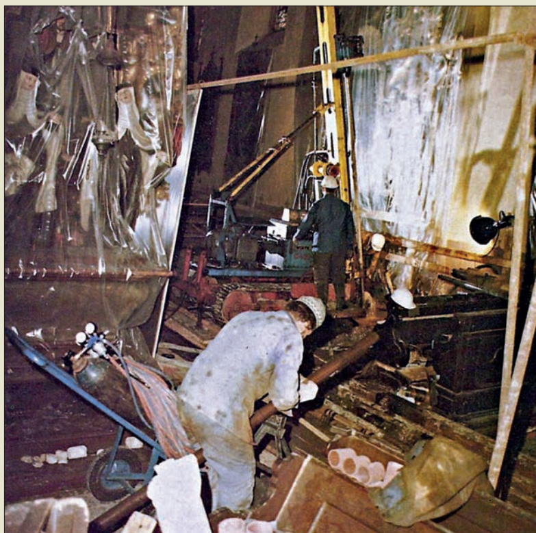
Obr. VI. 82: Vrtání pro mikropiloty 108/14 mm soupravou Wirth B0 a příprava jejich instalace uvnitř kostela sv. Mikuláše v Jaroměři roku 1972 závodem 07 podniku Vodní stavby (Zakládání staveb, a. s.)
