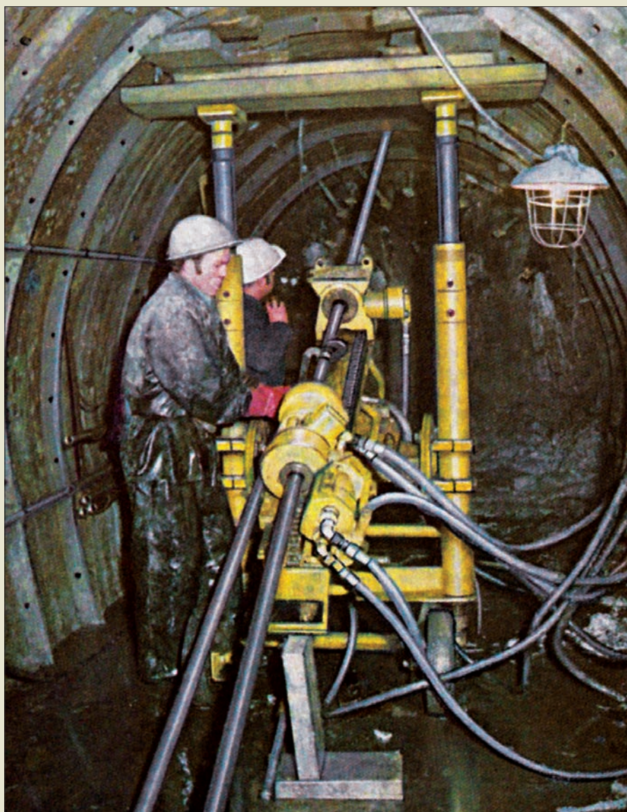
Obr. IV. 25: Jádrové vrtání plně hydraulickou soupravou Diamec 250 firmy AtlasCopco pro sanaci nadloží před ražbou traťového tunelu metra A pod Vltavou v roce 1973 (Zakládání staveb, a. s.)
