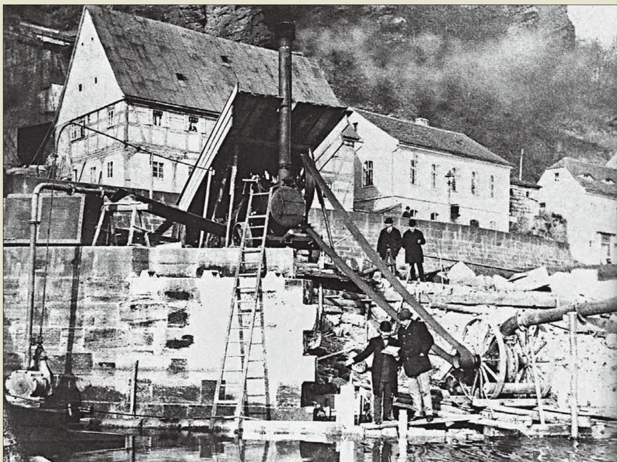
Obr. V. 5: Obvyklé uspořádání čerpání z jímky pro zřízení nábrežní zdi na stavbě zimního přístavu u děčínských Podmokel, prováděné v roce 1857 firmou Lanna. Vpravo je odstředivé čerpadlo poháněné parní lokomobílou a vlevo přímočinné parní čerpadlo pro napájení lokomobily. (Z. Bauer)
