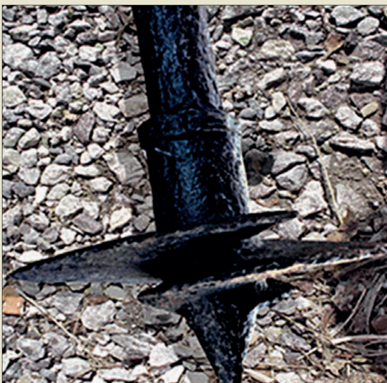
Obr. III. 18: Původní historická šroubovitá pilota Mitchellova typu
