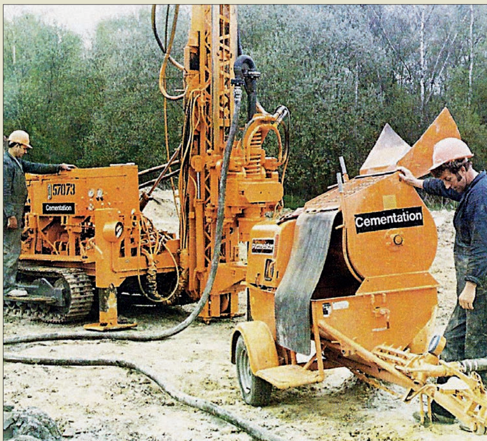
Obr. VI. 31: Typická sestava vrtné soupravy a míchačky s injekční pumpou Putzmeister, používaná pro zhuťňovací injektáž menšího rozsahu od roku 1986 britskou firmou Cementation
