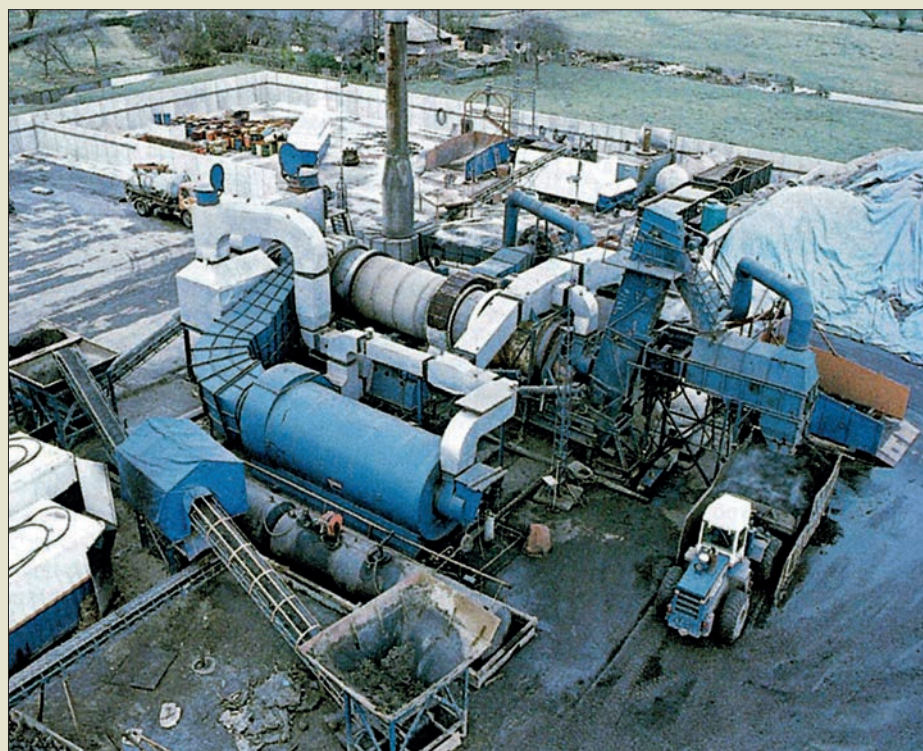
Obr. VI. 132: Typické mobilní zařízení pro dekontaminaci vytěžené zeminy termální extrakcí do 300 °C, používané nizozemskou firmou Ecotechniek na počátku osmdesátých let
