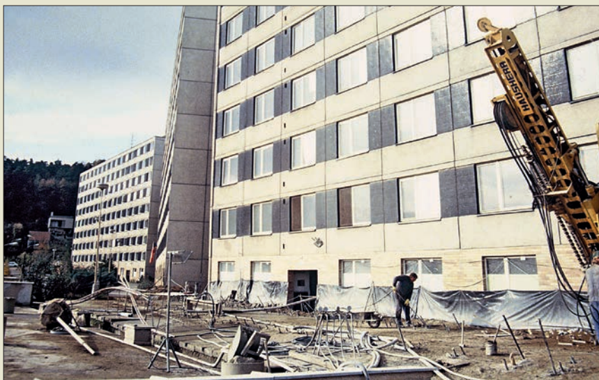
Obr. VI. 35: Dodatečná injektážní rektifikace devítipodlažního domu v Brně-Jundrově roku 1989 (Zakládání staveb, a. s.)
