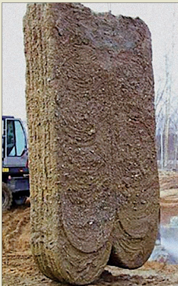
Obr. VI. 64: Ukázka vytěženého vzorku elementu soil-mixingu zhotoveného hydrofrézou typu CSM na zkušebním poli firmy Bauer roku 2009
