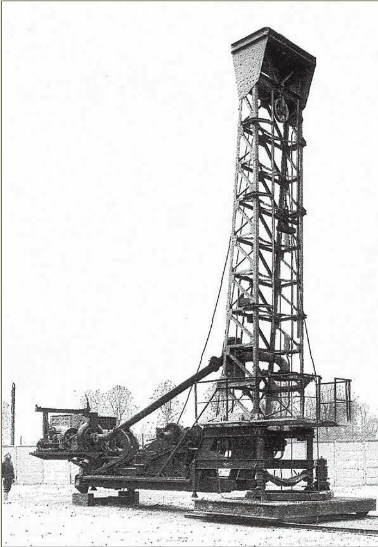
Obr. IV. 52: Vrtná souprava Rodio-Marconi CIS 61 firmy Soletanche pro nárazové vrtání s reverzní cirkulací výplachu výkonným odstředivým čerpadlem na elektrický pohon z roku 1950
