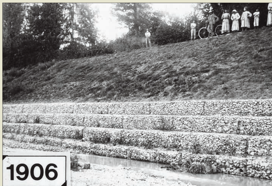
Obr. VI. 95: Jedna z prvních aplikací drátošterkových konstrukcí firmy Maccaferri pro historické opevnění v Itálii z roku 1906
