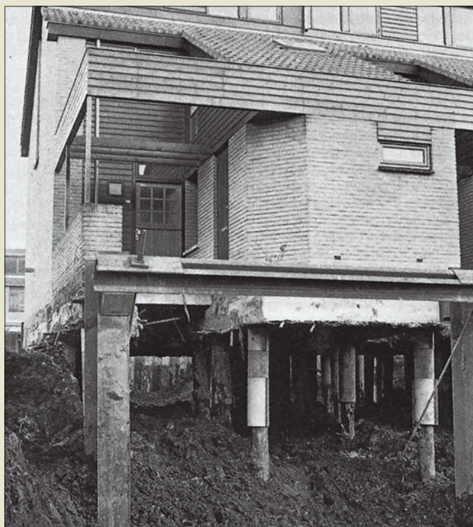
Obr. VI. 127: Odtěžování kontaminované zeminy pod domy na sídlišti Lekkerkerk v Nizozemsku roku 1980 pro přepravu k její likvidaci ex-situ ve spalovně
