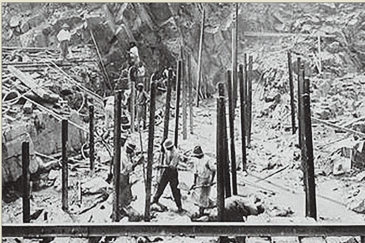
Obr. VI. 7: Cementová injektáž skalního podzákladí a zálivka kotevních kolejnic pro dno stavby skříně suchého doku v terminálu Balboa stavby Panamského průplavu v roce 1915
