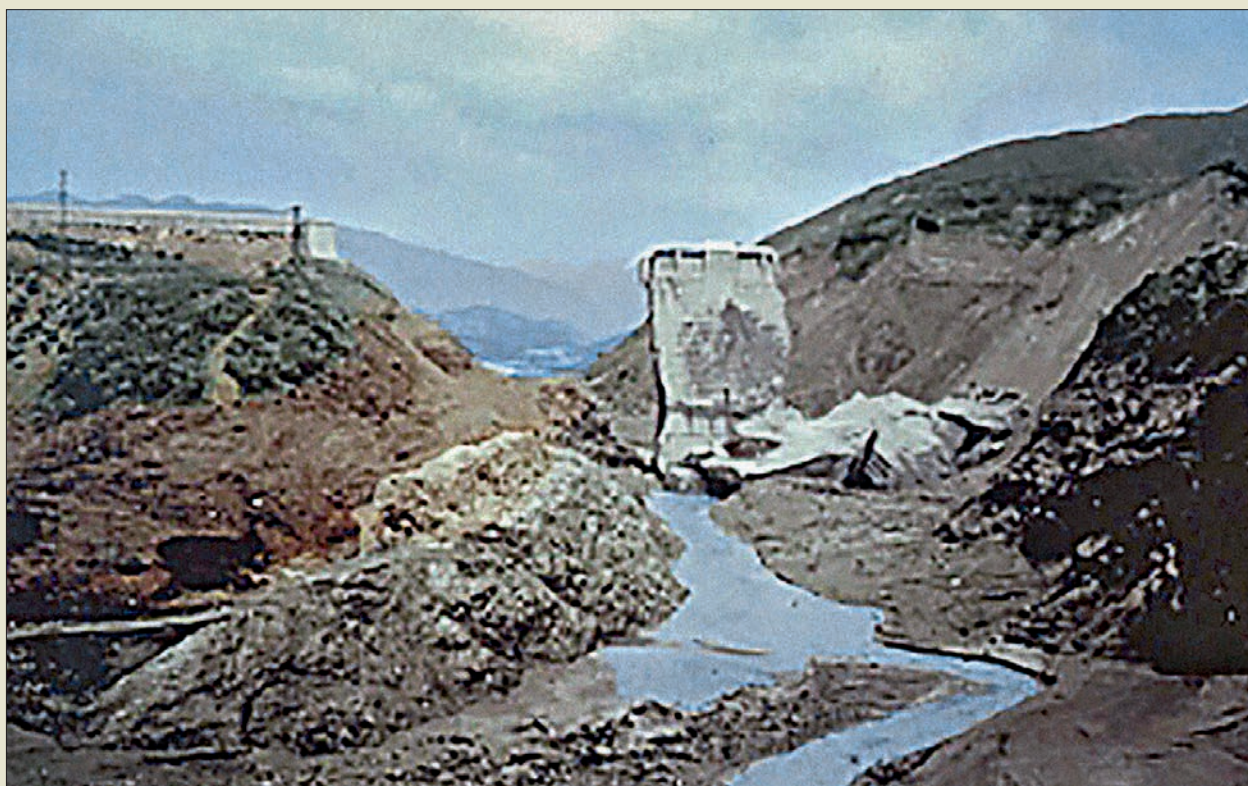
Obr. VI. 8: Trosky 62 m vysoké přehrady St. Francis v Kalifornii roku 1928, den po katastrofální poruše, která si vyžádala životy 425 lidí.
