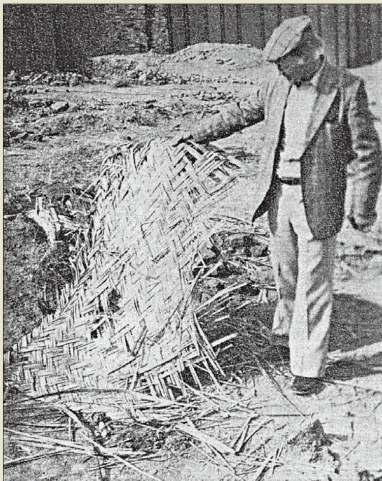
Obr. VI. 3: Rákosové rohože nalezené poblíž starověké stavby zigguratu Agarguf v Iráku z období kolem roku 1400 př. n. l., kde se vkládaly do pískových mezivrstev a plnily funkci vyztužení i odvodnění.
