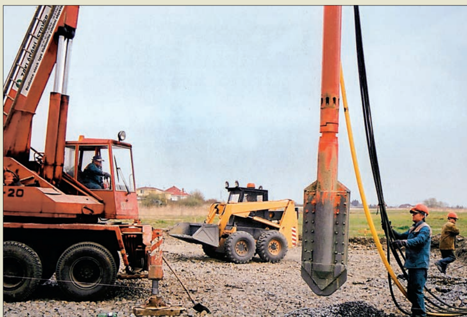
Obr. VI. 110: Použití hydraulického ponorného vibrátoru na stavbě Nedakonice roku 2005 (Zakládání staveb, a. s.)
