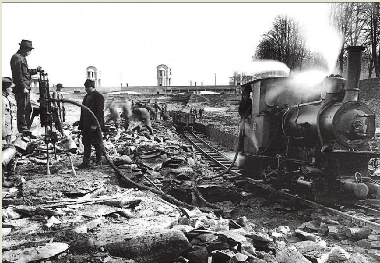
Obr. IV. 16: Vrtání původním Ingersollovým kladivem na trojnožce s improvizovaným parním pohonem z drážní lokomotivky při rozrušování úpek ve dně výkopu pro plavební komoru v Nymburce roku 1919 (Z. Bauer)
