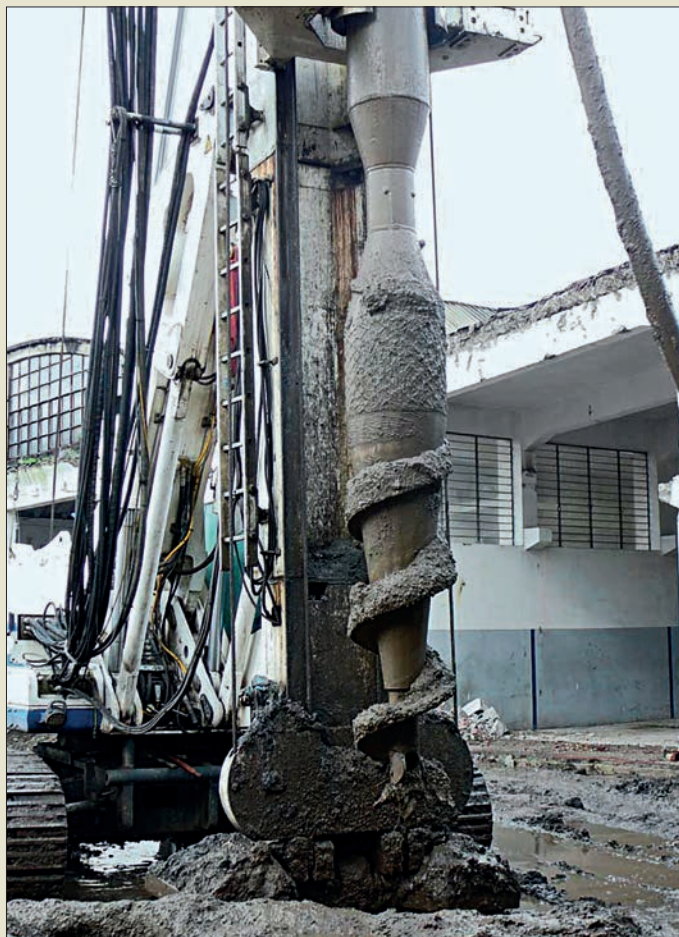
Obr. IV. 59: Vrtací nástroj firmy Soilmec pro BDP se zřetelnou boční klapkou pro betonáž na špici
