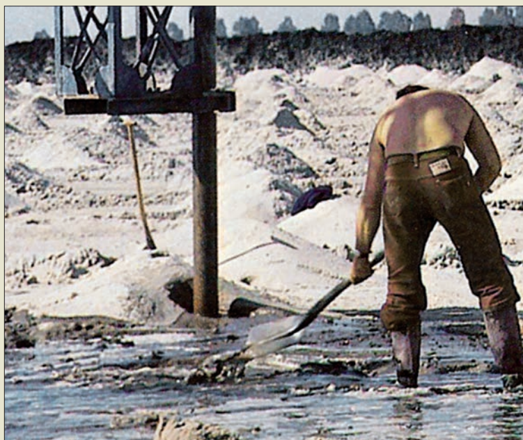
Obr. VI. 117: Instalační vrt pro pískový drén zhotovený vplachováním na stavbě komplexu námořních bariér pro ochranu vnitrozemí v Nizozemsku roku 1955. Výplň pískem byla prováděna ručně z předem připravených hromad materiálu.
