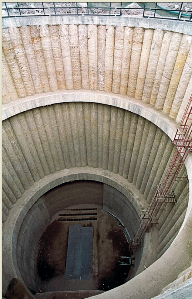
Obr. V. 39: Pilotová oválná stěna ze 70 převrtávaných pilot průměru 1,18 m, délky 40 m na stavbě železničního tunelu Březno v roce 2005. Jáma byla budována observační metodou. (Zakládání staveb, a. s.)
