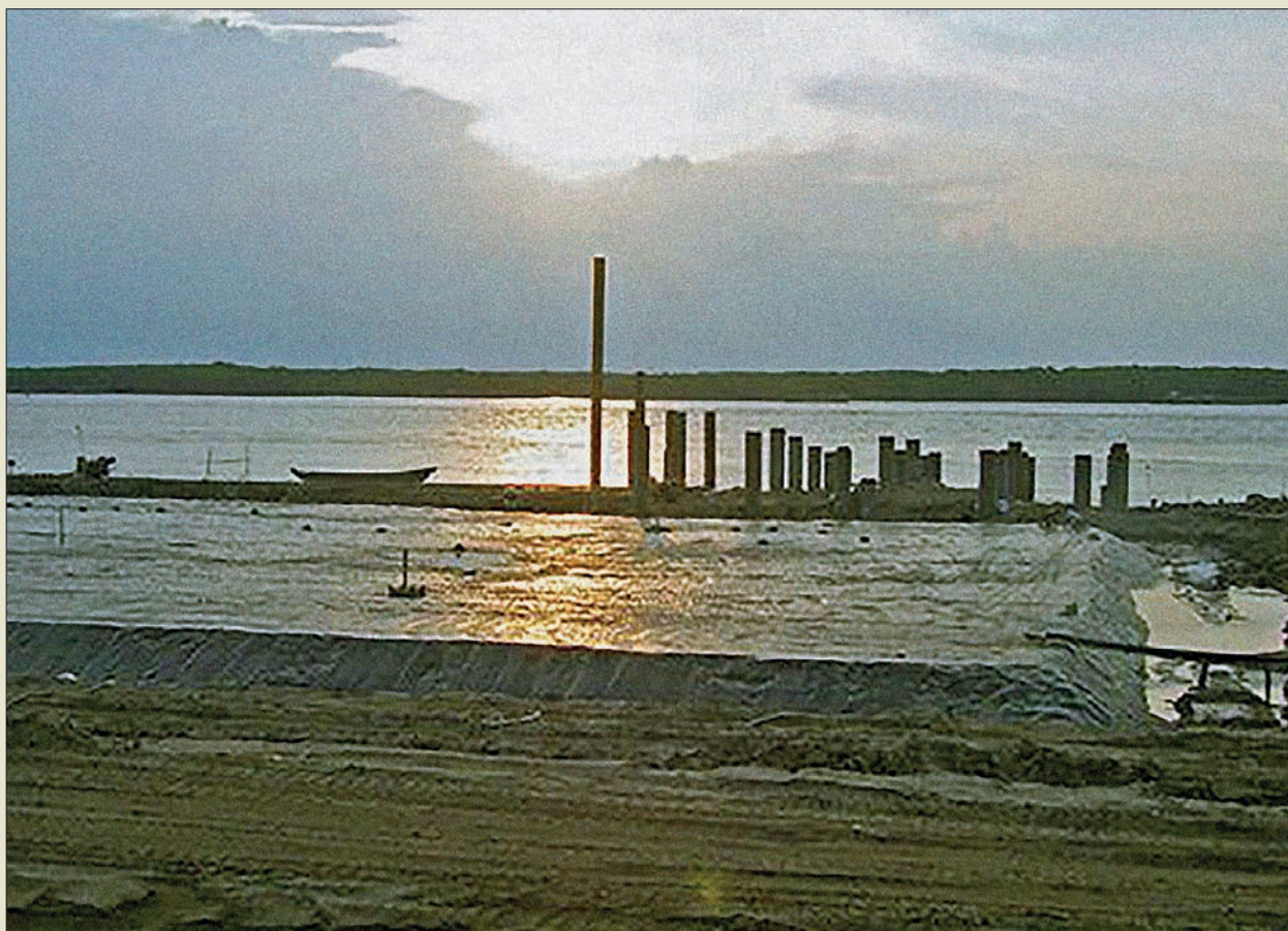
Obr. VI. 119: Vakuová konsolidace na stavbě kontejnerového terminálu Gemalink na řece Cai Mep River v jižním Vietnamu v roce 2010. Zlepšení vlastností měkkých jílů na ploše 600 x 60 m do hloubky 36 m prováděla firma Ménard.
