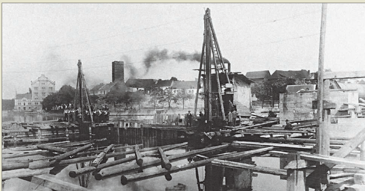
Obr. V. 31: Budování jezových jímek v Kolíně roku 1915 firmou Kapsa a Müller, v popředí parní beranidlo americké firmy Ingersoll při ražení štětovnic typu Ransome, v pozadí ruční beranidlo pro ražení dřevěných štětovnic (Z. Bauer)
