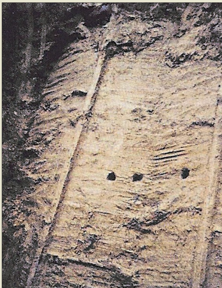
Obr. VI. 52: Výkopem obnažený kontrolní úsek těsnicí clony firmy Bachy z lamel tryskové injektáže roku 1993. Hloubka stěny byla 7 m, vzdálenost vrtů 3 m, úklon protínajících se lamel 45 a jejich tloušťka 15–35 cm.
