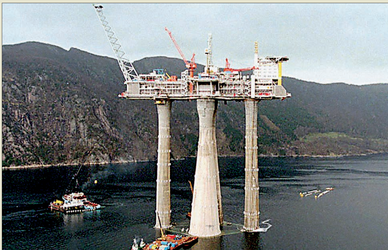
Obr. V. 13: Plavení vrtné plošiny Troll A, tvořené soustavou uzavřených železobetonových kesonů zhotovených postupně v mokřém doku o celkové výšce 469 m, na pozici těžby v Norsku roku 1996
