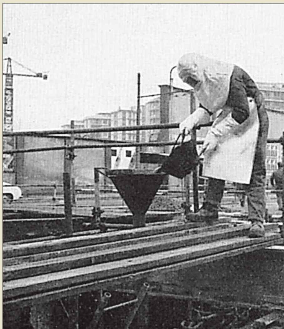
Obr. VI. 22: Gravitační injektáž firmy I.C.O.S. 160 °C horkým bitumenem pro utěsnění spáry konstrukce přechodu řeky Olony nad tunelem milánského metra roku 1962
