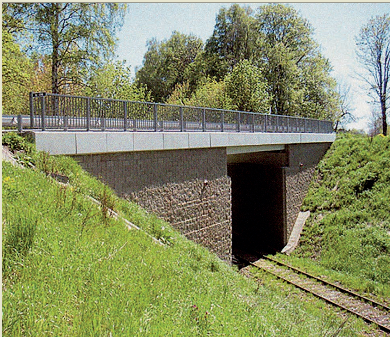
Obr. VI. 104: Mostní opěry z vyztužené zeminy pro silniční nadjezd u Královce, zbudované firmou Geomat roku 2004
