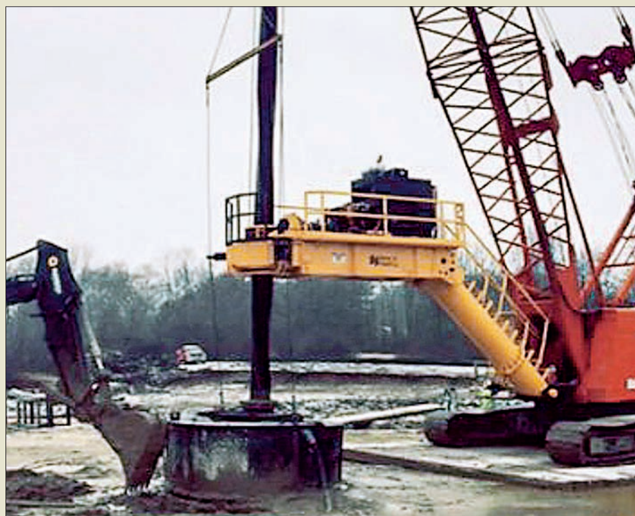
Obr. VI. 134: Souprava pro metodu soil-mixing s chemickým ošetřením, používaná podle patentu firmy Geo-Con v USA roku 2011
