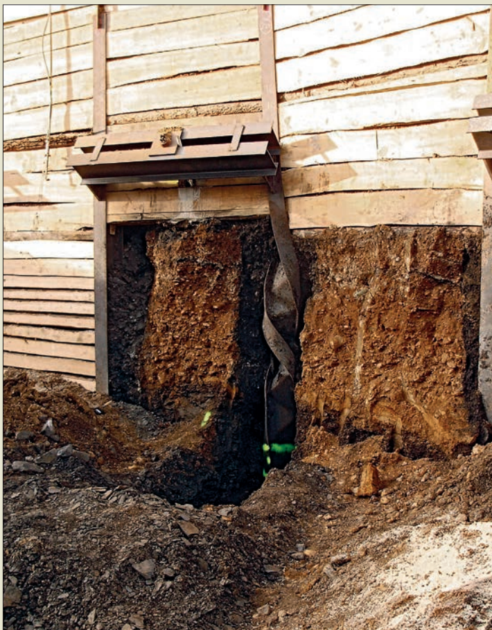
Obr. IV. 47: Doklad o mocnosti krouticího momentu pilotovacích souprav používaných v roce 2010 – čerstvě instalovaný zkroucený I-nosník záporný, zaklíněný při odpažování vrtu
