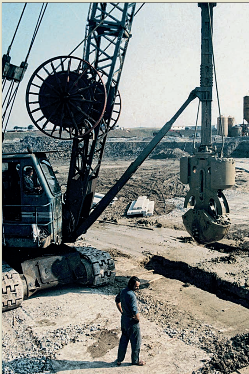
Obr. V. 73: Těsnicí podzemní stěna ze samotvrdnoucí suspenze pro úložiště popílkových kalů v Počeradech, těžená vedeným kelly drapákem (Zakládání staveb, a. s.)
