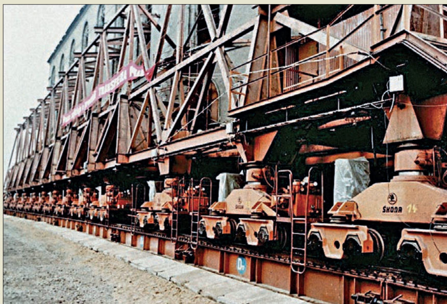
Obr. VI. 34: Skřínky elektronicky snímané hydrostatické nivelace (zakryté fólií) s okamžitým přenosem dat do centrály Hottinger, umístěné na podvozcích při přesunu mosteckého kostela Nanebevzetí Panny Marie roku 1975
