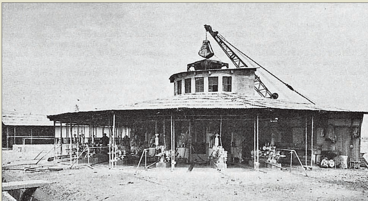
Obr. VI. 23: Velká výrobní směsi a injekční stanice na počátku šedesátých let na stavbě injekční clony pro přehradu
