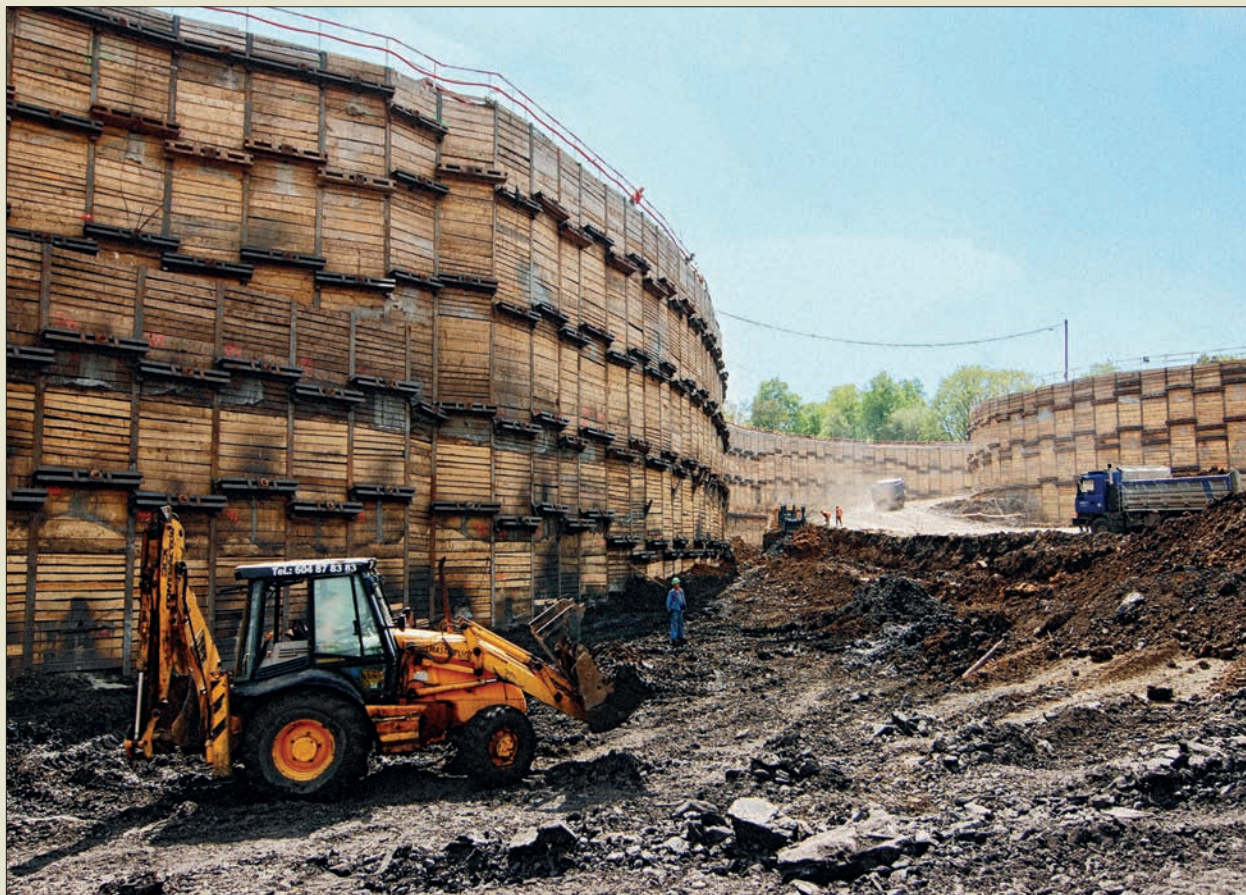
Obr. V. 37: Výhodné použití kotveného záporového pažení v členité geometrii portálové jámy hloubeného tunelu Blanka na Letné v roce 2008, hloubka v zachyceném místě byla cca 22 m. (Zakládání staveb, a. s.)
