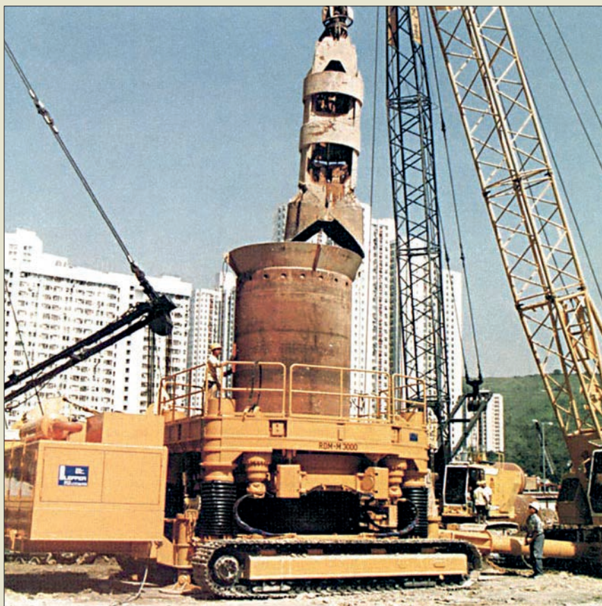
Obr. IV. 41: Zapažovací rotátor firmy Leffer RDM-M 3000 pro výpažnice o průměru 3 m do hloubek 85 m
