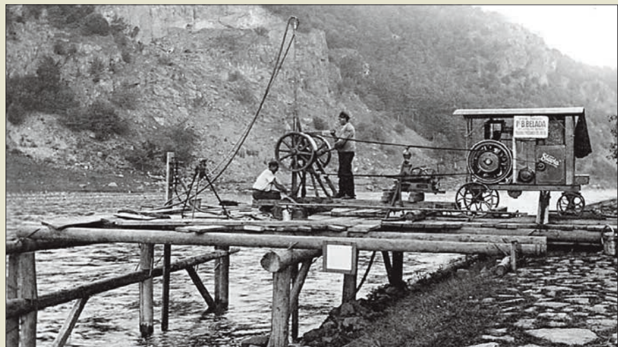
Obr. IV. 24: Průzkumné vrtání jádrové „na šrot“ pro výstavbu Slapské přehrady na Vltavě, prováděné firmou Belada v roce 1928. Sestavu vrtačky a výplachového čerpadla poháněla motorová lokomobila Slávia (Z. Bauer).
