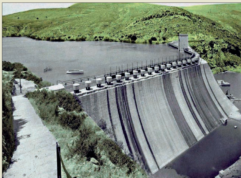
Obr. VI. 89: Přehrada Cheurfas v Alžírsku byla roku 1934 přikotvena v koruně 37 kabelovými kotvami.
