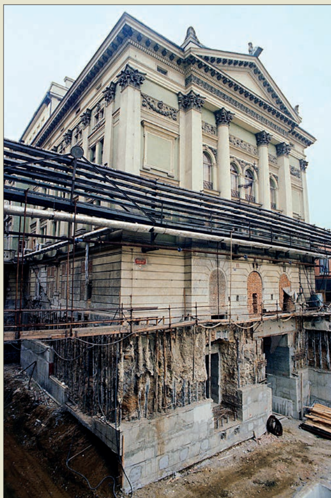
Obr. V. 40: Mikropilotové stěny použité pro zajištění budovy Stavovského divadla v Praze při prohlubování suterénů v roce 1986 (Zakládání staveb, a. s.)
