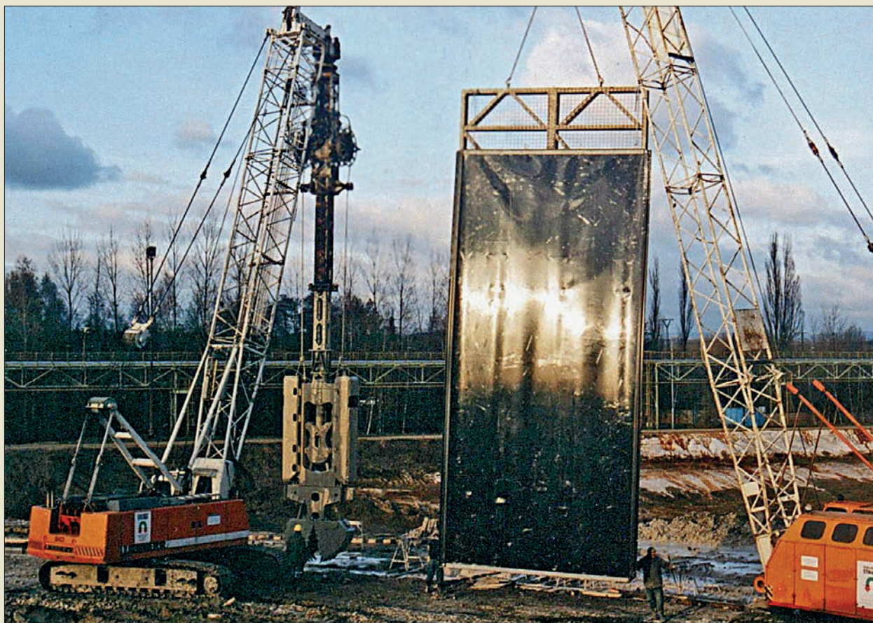
Obr. V. 80: Osazování geomembrány z PEHD tloušťky 2 mm do hloubky 10 m v těsnicí podzemní stěně při nové úpravě skládky zelené skalice v Precheze Přerov roku 2001 (Zakládání staveb, a. s.)
