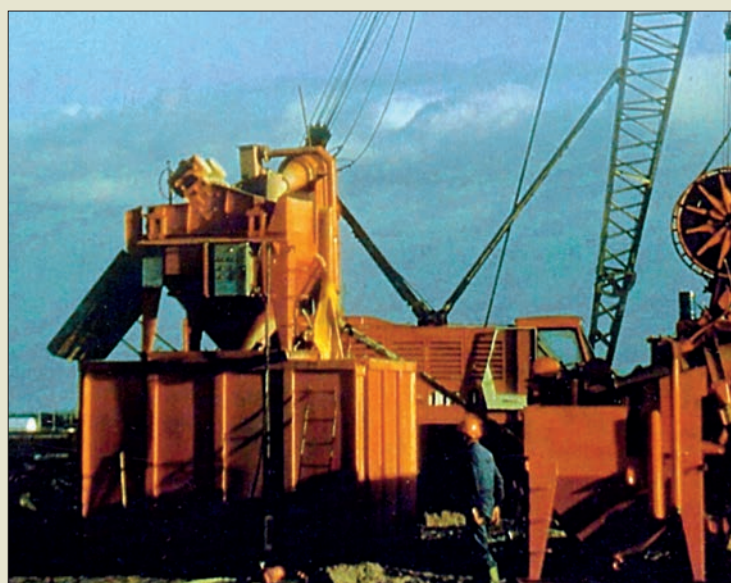
Obr. V. 59: Kompaktní čistička bentonitové suspenze Caviem s hrubým a jemným štěrbinovým vibrosítem a s velkým hydrocyklonem na stavbě podzemních stěn s drapákovou těžbou na začátku osmdesátých let
