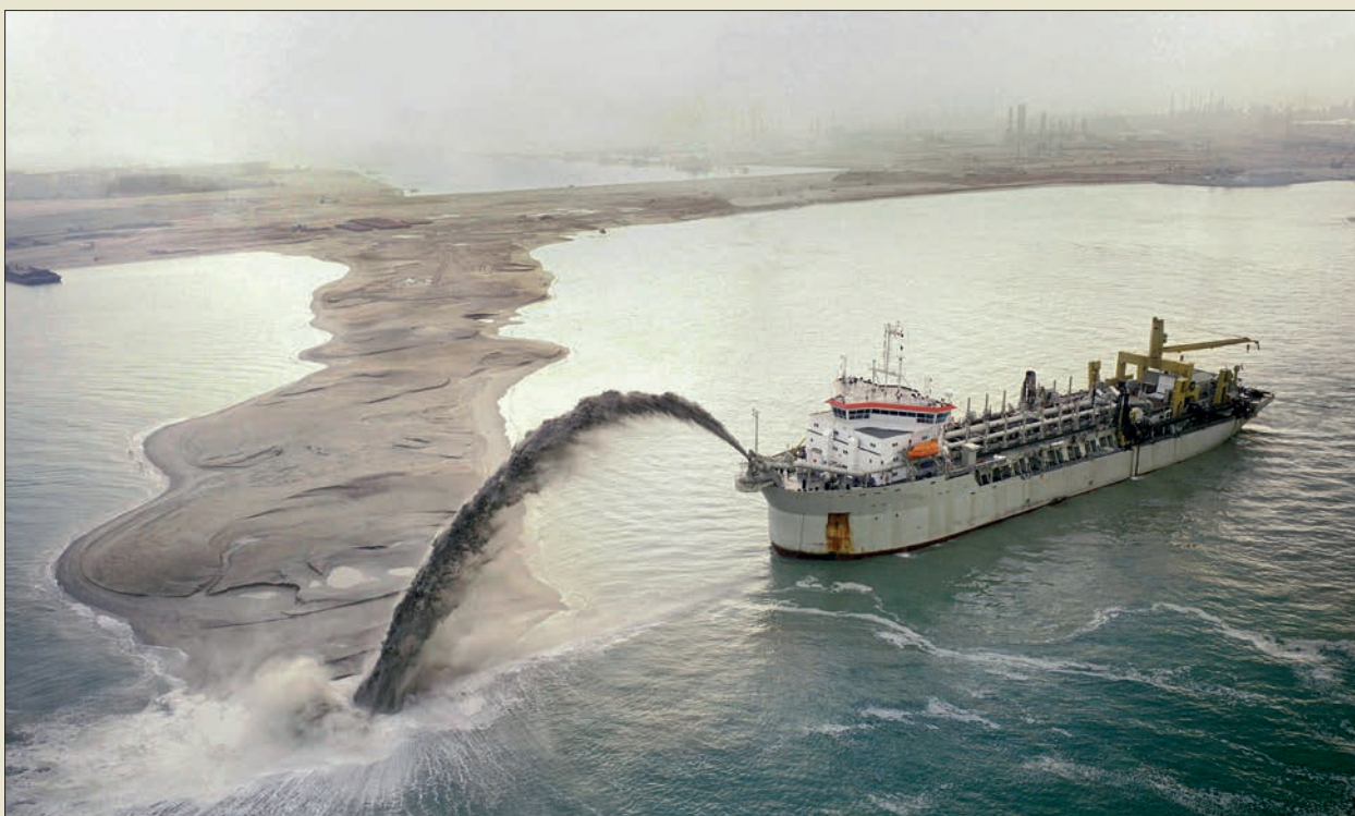
Obr. V. 9: Příklad velkokapacitního námořního sacího bagru s velkým zásobním lodním prostorem, z kterého může naplavovat umělé pobřeží z jinde odtěženého materiálu na konci 20. století.
