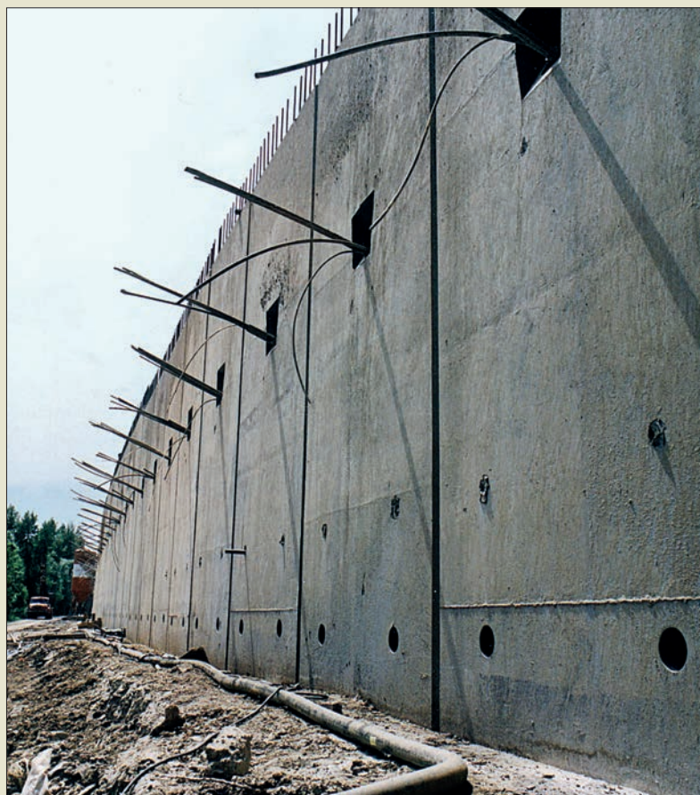
Obr. V. 66: Osazené prefabrikované panely podzemní stěny před ukotvením na Strakonické ulici v Praze roku 2001 (Zakládání staveb, a. s.)
