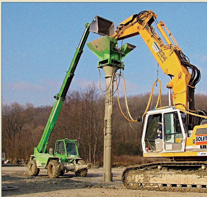
Obr. VI. 80: Přídavný hydraulický průchozí ponorný vibrátor firmy Soletanche-Bachy zvaný „stitcher“, nasazený na konvenční hydraulické rypadlo při provádění štěrkových sloupů o hloubce 4–6 m pro zlepšení jílovitého podzákladí pod násypem opěry mostu na stavbě dálnice D8 v ČR roku 2004
