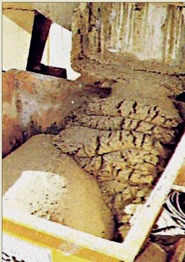
Obr. VI. 28: Hustá cementová injekční směs používaná pro zhutňovací injektáž firmy Bachy v Evropě od roku 1985
