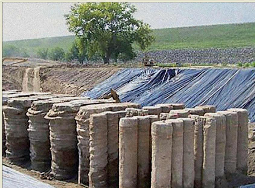
Obr. VI. 67: Porovnání tvarů odkopaných výsledných elementů z trojfázové tryskové injektáže (vlevo) a z kombinace soil-mixingu s tryskovou injektáží systémem Trevi-Jet na zkušební poli pro rekonstrukci přehrady Tuttle Creek v americkém Kansasu roku 2007
