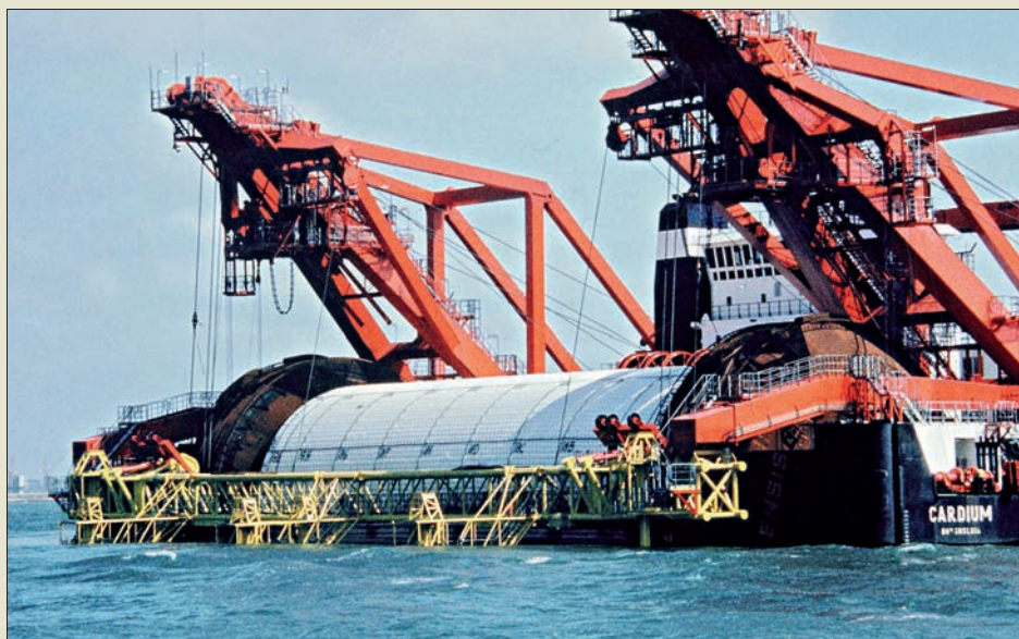
Obr. VI. 99: Podmořské ukládání prefabrikované roznášecí a filtrační matrace do hloubky 30 m speciální lodí Cardium při výstavbě bariéry Oosterschelde v Nizozemsku na počátku osmdesátých let
