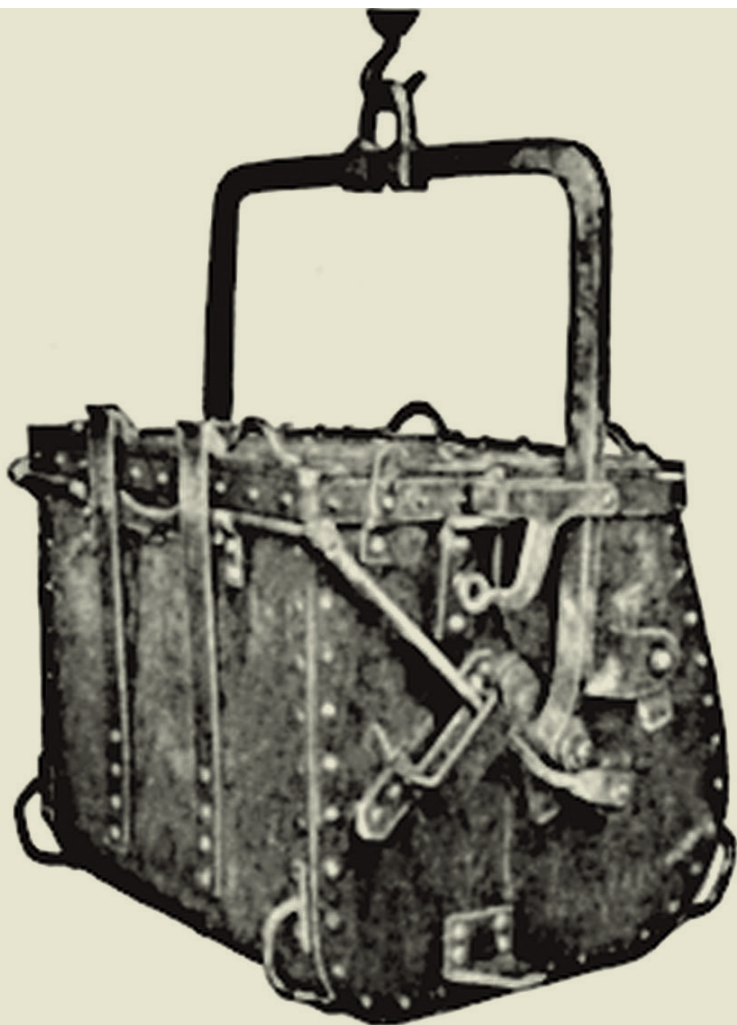
Obr. V. 23: „Kyklopský“ betonážní ponorný uzavřený koš z oceli používaný v USA na začátku 20. století
