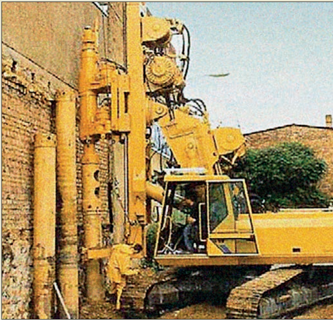
Obr. IV. 57: Provádění pilot CAP výpažnicovou technologií těsně u stěny stávajícího objektu roku 2013
