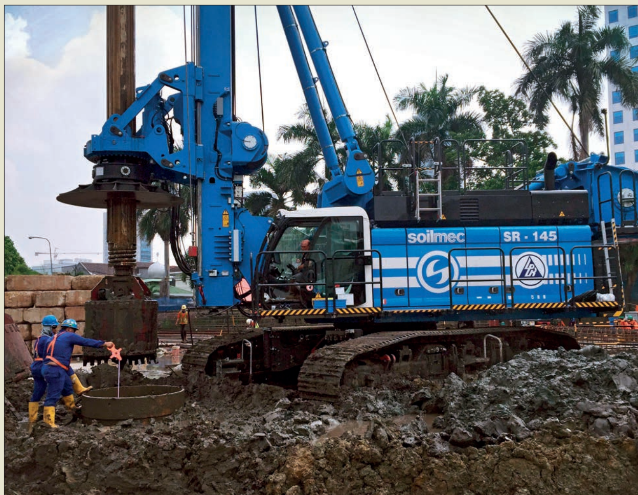
Obr. VII. 3: Vrtání pilot o průměru 1,5 m do hloubky 87 m v jílovitosiltovitých zeminách soupravou Soilmec SR 145 o váze 145 t pro založení mrakodrapu v indonéské Jakartě firmou Trevi roku 2017. Vrt byl vibračně zapažen ocelovou výpažnicí do 15 m a dále prováděn pod polymerovým výplachem.
