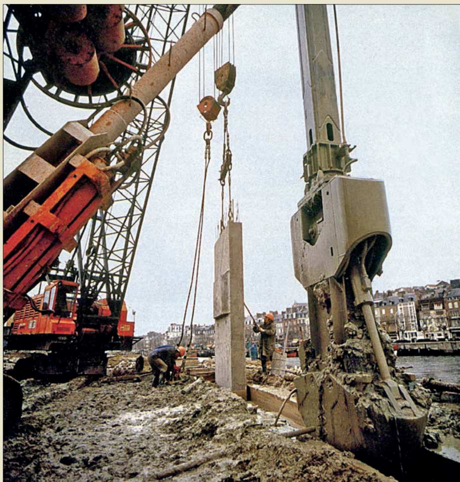
Obr. V. 65: Provádění prefabrikované podzemní stěny Panosol firmy Soletanche pro nábřeží v normanském letovisku Deauville-Trouville ve Francii roku 1977
