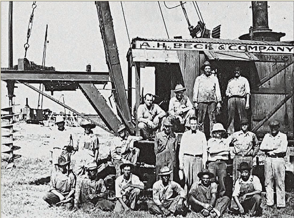
Obr. IV. 42: Jedna z prvních vrtných souprav pro vrtání pilot s nástavbou na parním bagrjeřábu ve třicátých letech 20. století v USA
