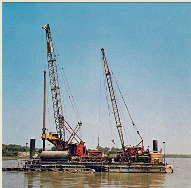
Obr. IV. 45: Vrtání pilot kombinací technologie drapákové těžby se samostatně zavibrovanou výpažnicí a rotační bentonitové technologie v řece Tigris pro založení mostu Jadiriah Bridge v iráckém Bagdádu roku 1982 firmou Rodio
