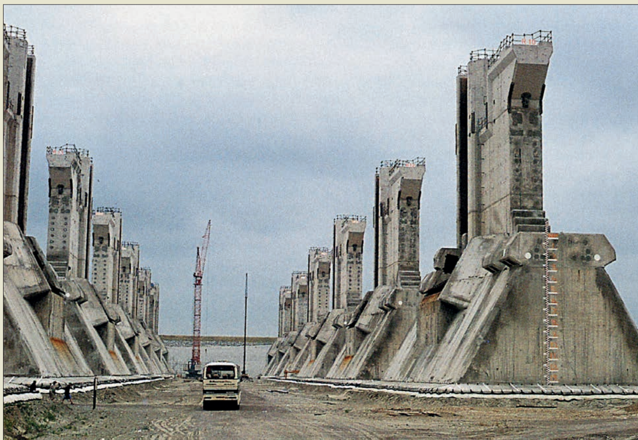
Obr. V. 12: Pilíře z předpjatého betonu hráze Oosterschelde v nizozemském Deltaprojektu po dokončení výroby v suchém doku roku 1984 před začátkem splavování na pozici
