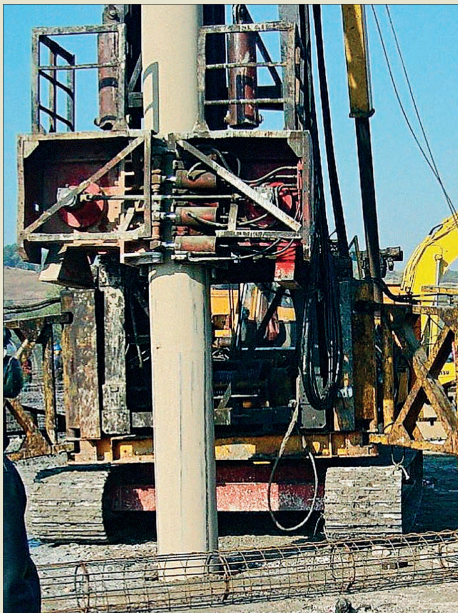
Obr. III. 12: Vibrační odpažovací objímka legendární světově rozšířené soupravy Fundex F12 pro piloty typu Vibrex na stavbě v Polsku v devadesátých letech
