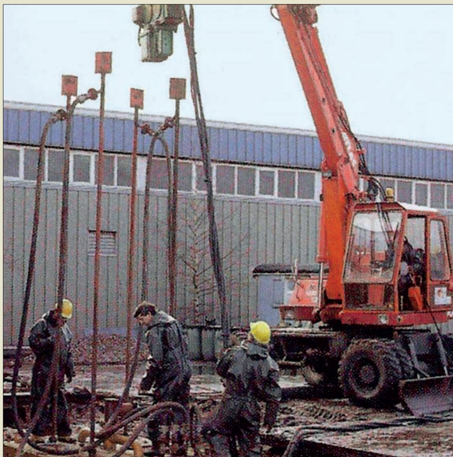
Obr. VI. 133: Vibrační zarážení jehel pro metodu parního stripování polutantů, použitou prvně v Nizozemsku roku 1984 firmou Heidemij
