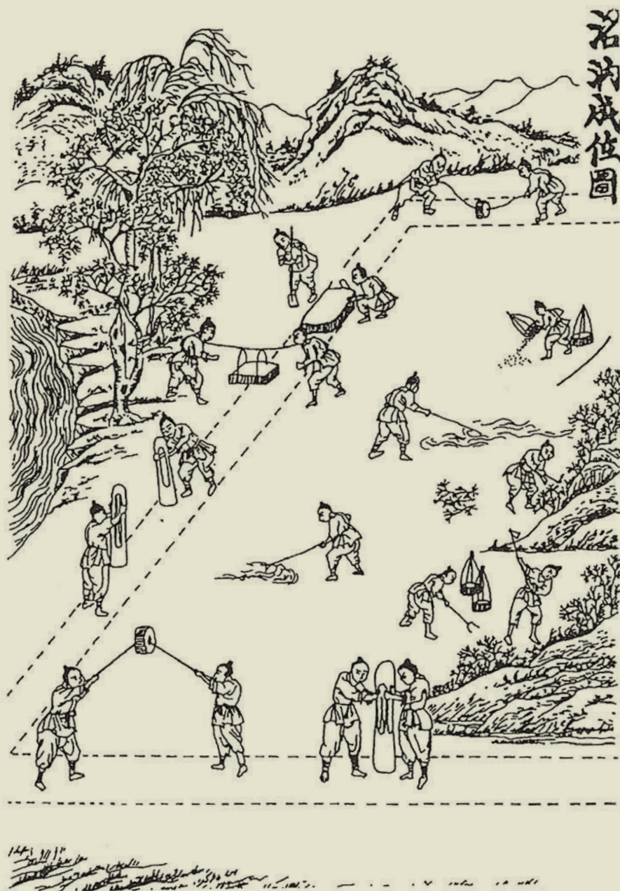
Obr. VI. 107: Příprava staveniště s různými postupy zhutňování podkladu pro základy po předepsaných tenkých vrstvách s prolohami zrnitého materiálu podle předpisu čínské dynastie Sung roku 1103
