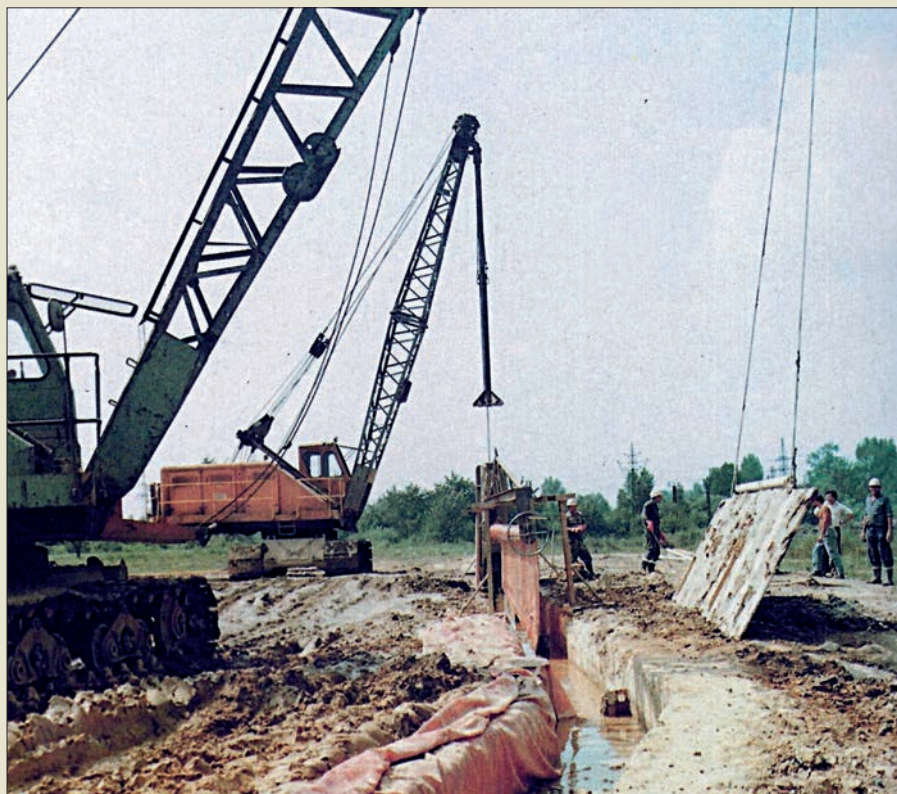
Obr. V. 79: Budování těsnicí clony s geomembránou kolem skládky agresivní zelené skalice v chemičce Přerov v roce 1981. Fólie Isofol z měkčeného PVC byla instalována do hloubky 7 až 9 m. (Zakládání staveb, a. s.)
