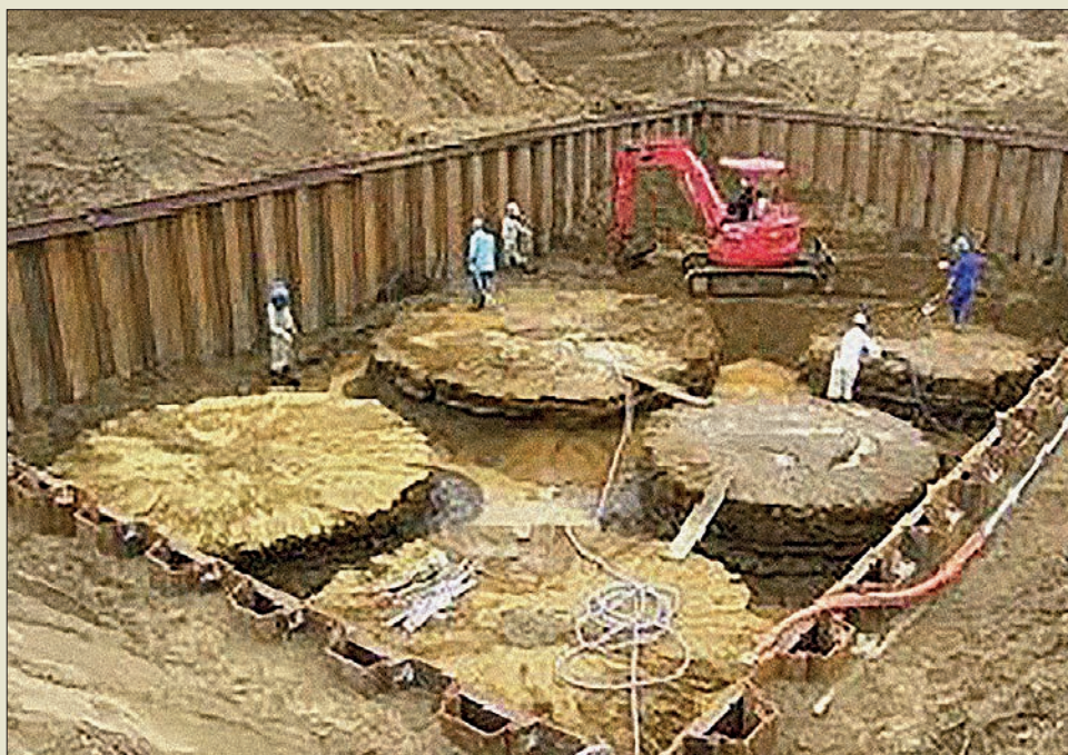
Obr. VI. 54: Zkušební pole se sloupy tryskové injektáže o průměru až 5,5 m zhotovenými inovativním postupem „V-JET Technology” japonské firmy JBP roku 2013
