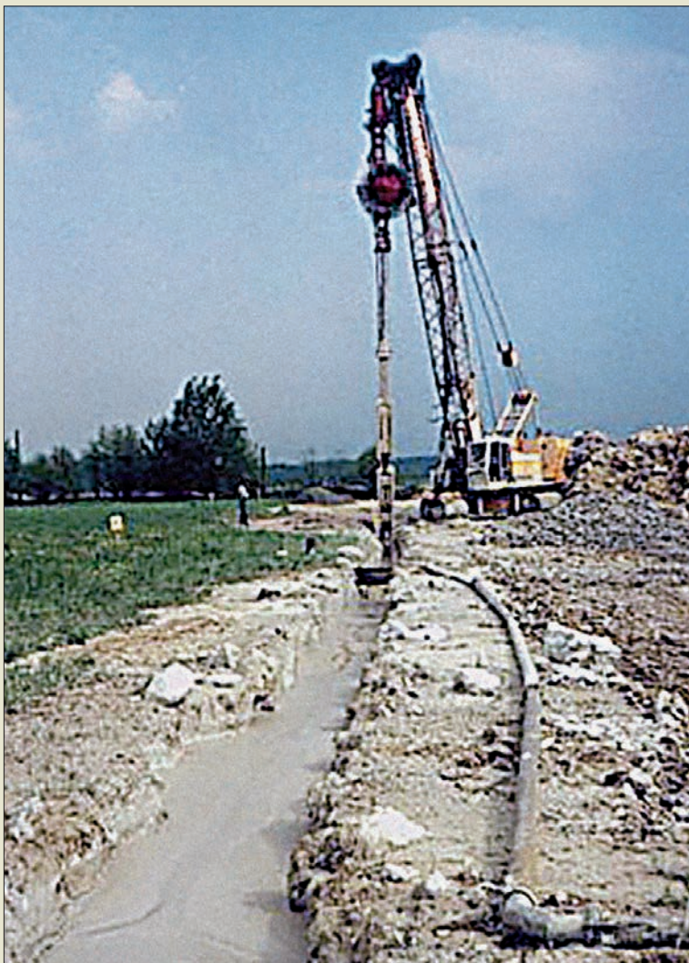
Obr. V. 78: Zřizování těsnicí stěny tloušťky 60 cm ze speciální samotvrdnoucí suspenze drapákovou technologií firmou Soletanche ČR v rámci zhotovení úplného geokontejnmentu skládky toxických odpadů Kema Skalná v roce 1997
