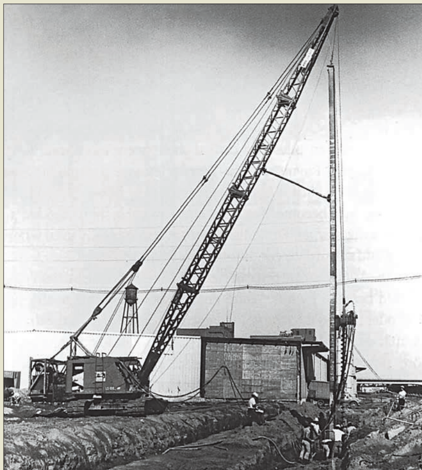
Obr. IV. 55: Jedno z prvních provádění pilot ACIP americkou firmou Intrusion Prepakt roku 1950
