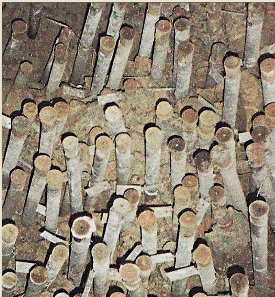
Obr. VI. 17: Příklad velmi účinného hustého rozmístění injekčních vrtů pro vějíře při injektáži z podzemí firmou Soletanche na stavbě linky U3 vídeňského metra roku 1986
