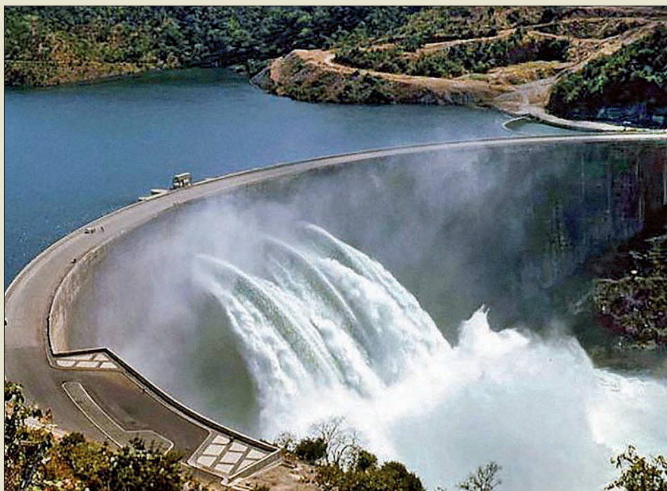
Obr. VI. 41: Klenbová přehrada Kariba na řece Zambezi mezi Zambií a Zimbabwe při plné funkci povodňových výpustí. Pro zřizování její těsnicí clony bylo v roce 1955 rozsáhle uplatněno tryskové vyplachování horninových puklin.
