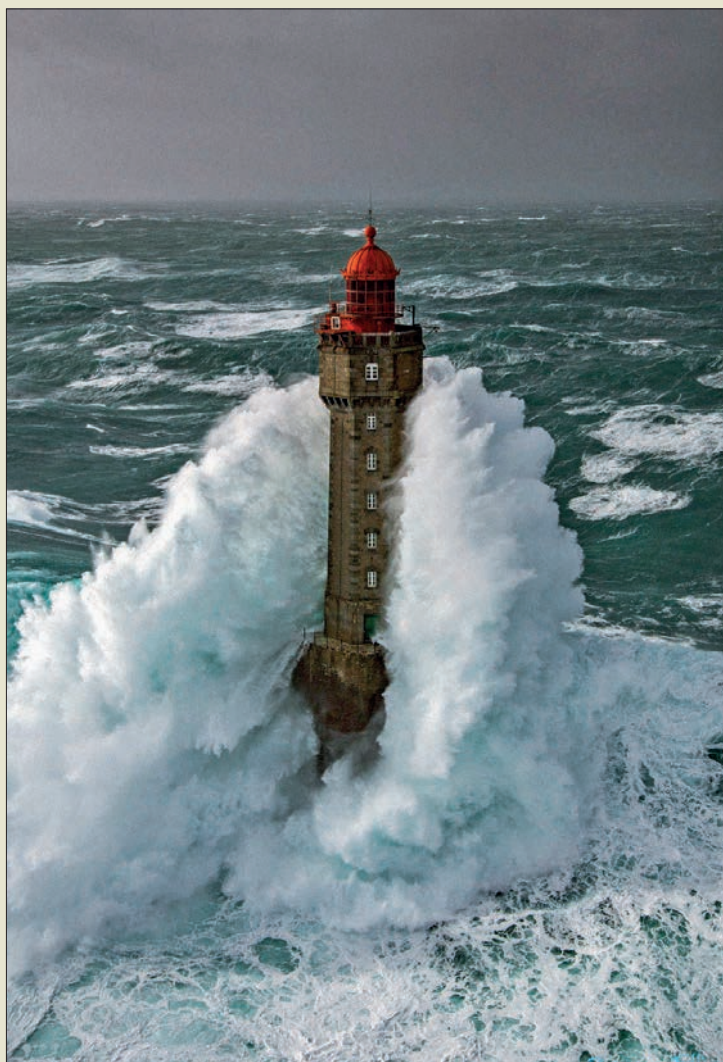
Obr. VI. 88: Bretaňský maják La Jument v bouřlivé mořské oblasti dodatečně přikotvený do žulového podloží v roce 1930
