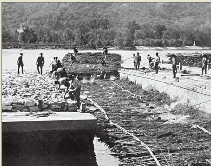
Obr. VI. 98: Opevňování regulační hráze koryta Mississippi proutěnými matracemi a kamenným záhozem roku 1890
