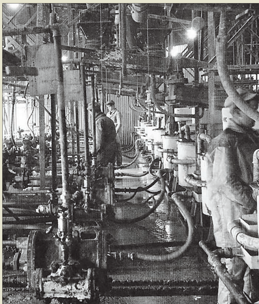
Obr. VI. 24: Injekční stanice firmy Soletanche na stavbě pařížského metra na počátku sedmdesátých let
