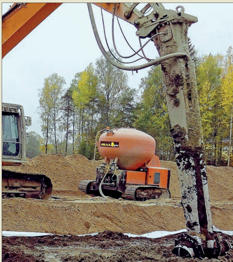
Obr. VI. 65: Souprava finské firmy Allu s frézovou míchací hlavicí na výložníku hydraulického rypadla při provádění „suché“ metody roku 2011
