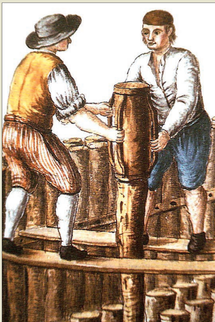
Obr. VI. 68: Lehké ruční beranění relativně krátkých dřevěných pilot ve velmi těsných roztečích v základovém prostředí nekonsolidovaných mořských náplavů v Benátkách v 18. století
