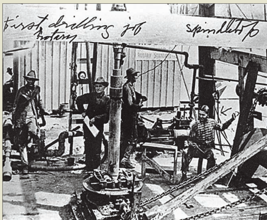
Obr. IV. 5: Vrtací stůl a soustrojí rotační soupravy s posádkou slavného vrtu A. F. Lucase na nalezišti Spindletop v Texasu roku 1900
