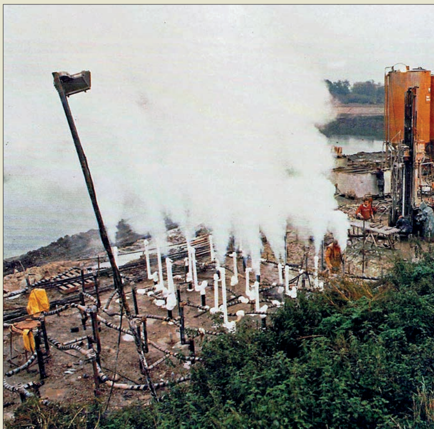
Obr. VI. 122: Pracoviště firmy Stent Foundations pro zmrazování tekutým dusíkem do hloubky 30 m na stavbě vodního tunelového přivaděče Iver o průměru 2,54 m v Buckinghamshire v Anglii roku 1985. Je patrné volné odvětrávání vrtů.
