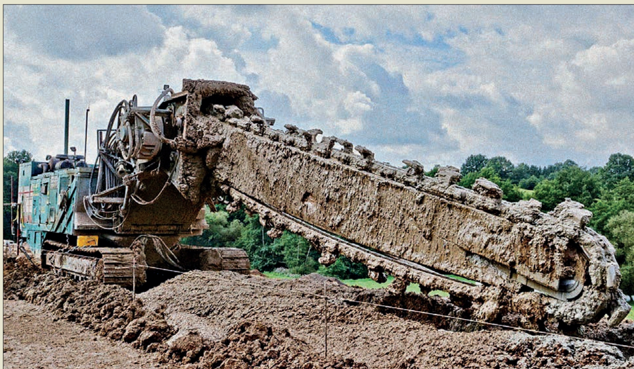
Obr. VI. 62: Řetězová fréza typu FMI pro soil-mixing německé firmy Allcon během stabilizace železničního tělesa St. Wendel do hloubky 9 m při tloušťce 0,5 m roku 2014
