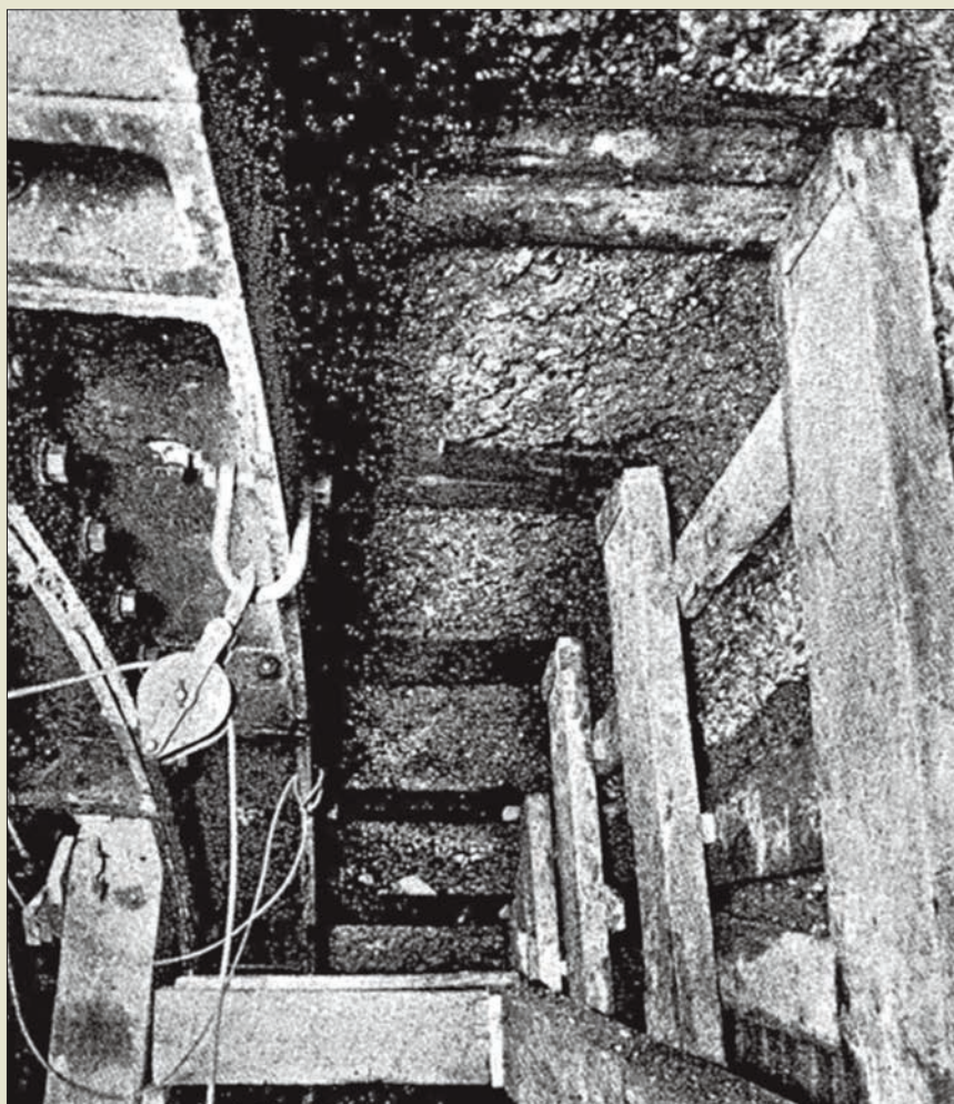
Obr. VI. 19: Zvodnělé a kypře temžské štěrkopísky byly spolehlivě zainjektovány metodou Joosten i ve stropě při ražbě tunelu londýnského metra u stanice Bank Monument roku 1933.
