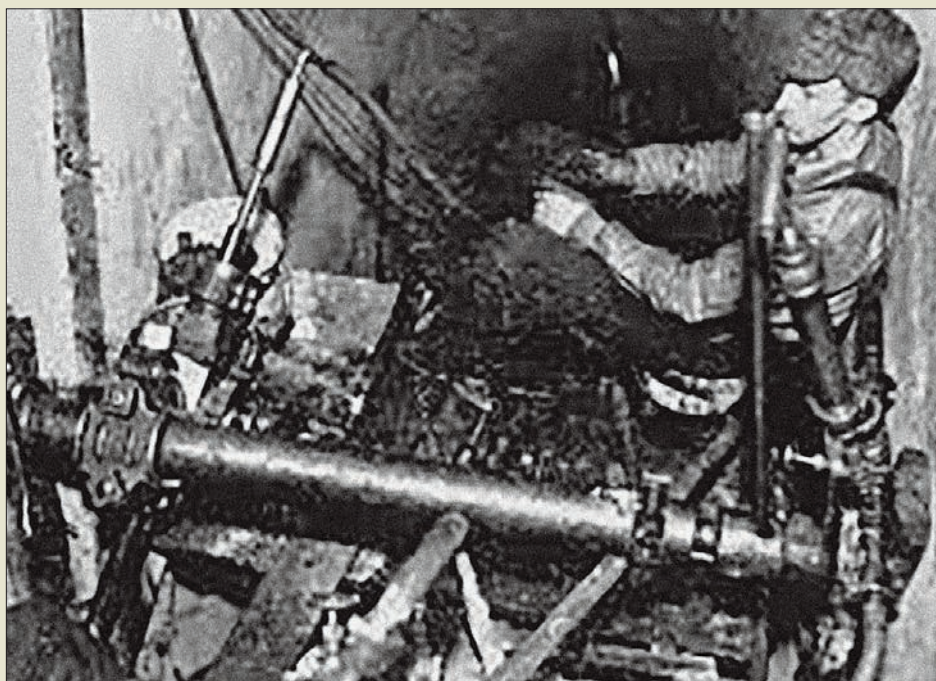
Obr. VI. 12: Opravná injektáž ze štoly Hooverovy přehrady v letech 1938 až 1947
