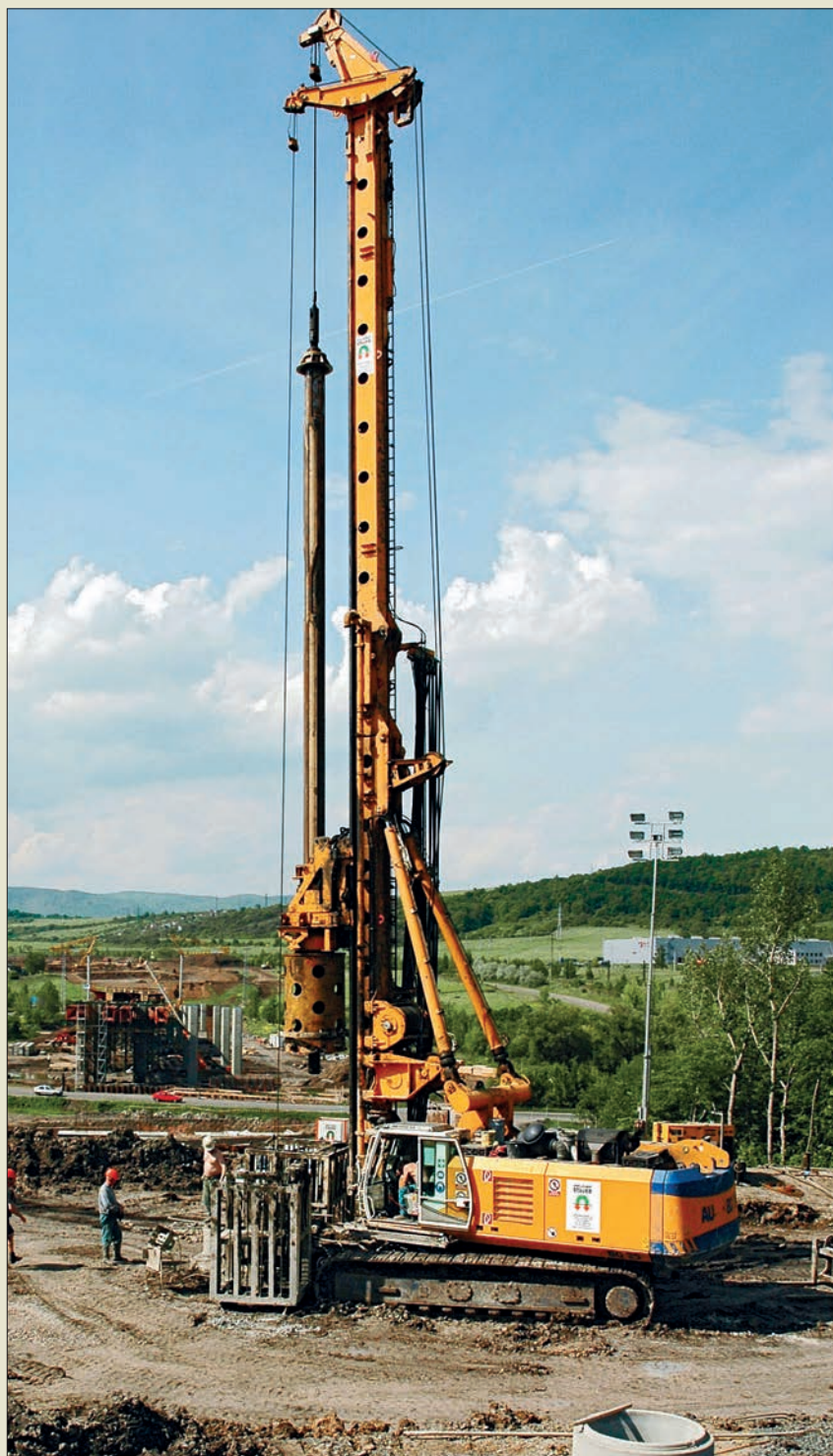
Obr. IV. 46: Typická pilotovací souprava Bauer BG 25 se svislou lafetou nesenou paralelogramem a s posuvnou vrtnou hlavou zavrtávající výpažnici roku 2003 (Zakládání staveb, a. s.)
