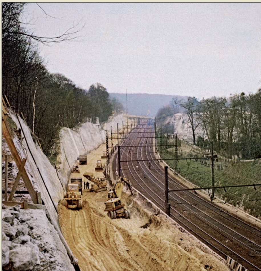
Obr. VI. 93: Zajištění svahu hřebíkováním v písčitých zeminách pro rozšíření železnice ve Versailles firmou Soletanche roku 1972
