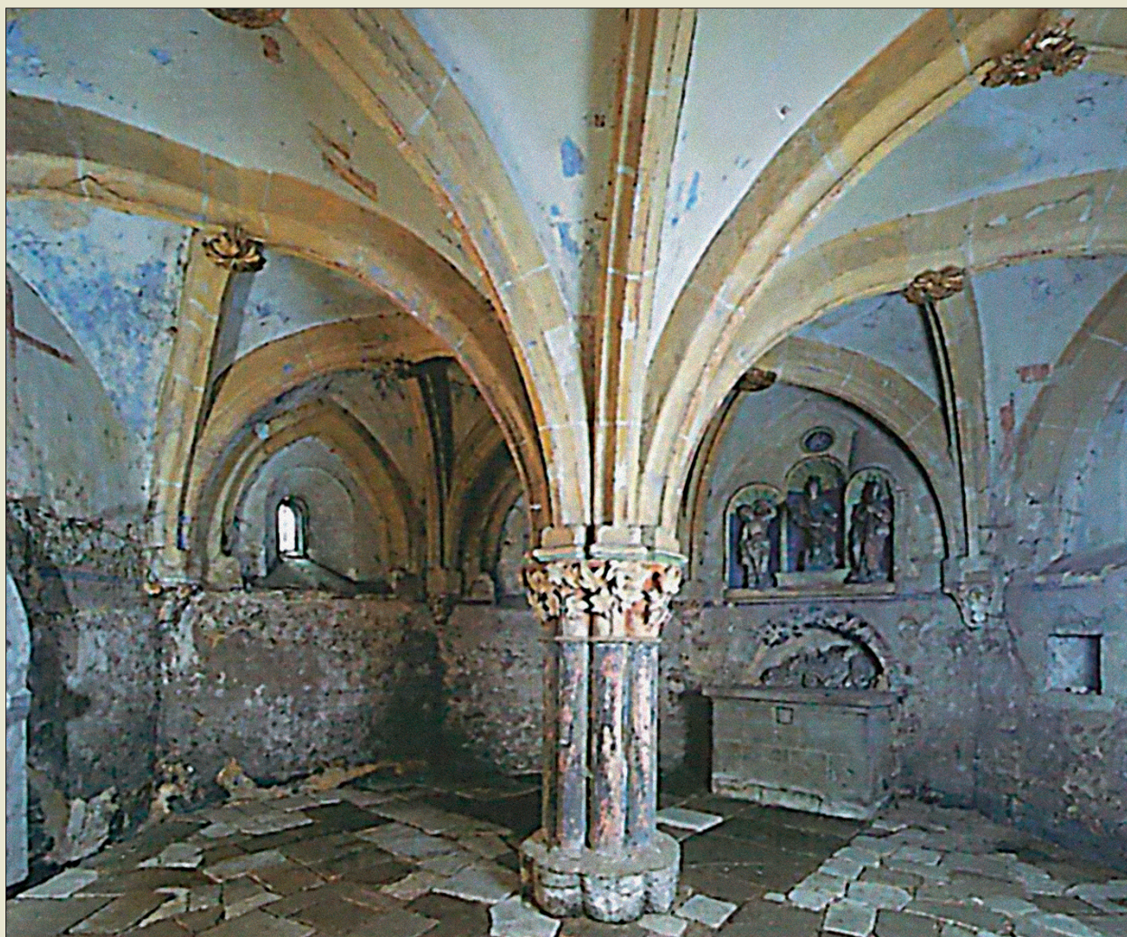
Obr. IX. 1: Unikátní hvězdnicová klenba v podzemní kapli sv. Kateřiny v kouřimském kostele sv. Štěpána z 13. století před restaurováním roku 1999
