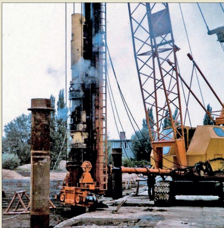
Obr. VI. 77: Souprava pro zřizování předražených pilot s dieselberanem Delmag a vibrační elektricky poháněnou odpažovací objímkou vlastní konstrukce závodu SZS, Vodní stavby, na východoněmeckém nosiči RDK na stavbě u Duchcova roku 1984
