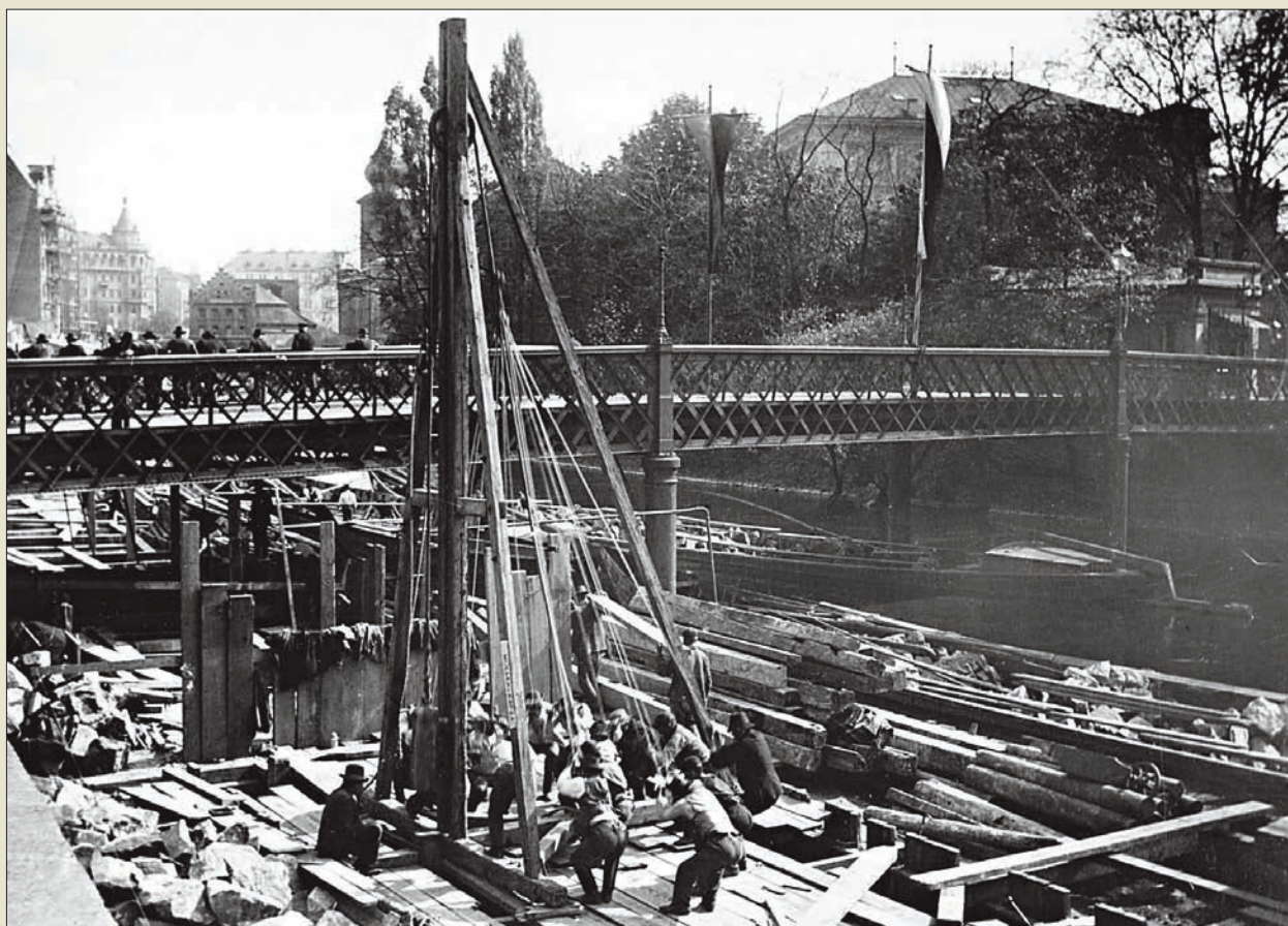
Obr. III. 6: Beranění dřevěné piloty volnopádovým beranem zdvihaným 14 muži na stavbě nábrežní zdi u Národního divadla v Praze roku 1902 (Z. Burian)
