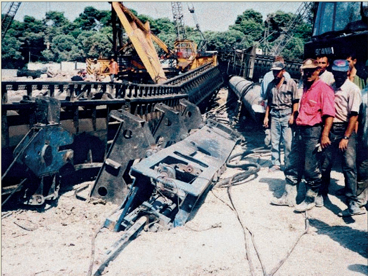
Obr. III. 21: Zřícená 30 m vysoká věž těžké pásové pilotovací soupravy Fundex F15 na stavbě v tureckém Izmiru v roce 1998 po přesunu na nedostatečně upravené pracovní ploše
