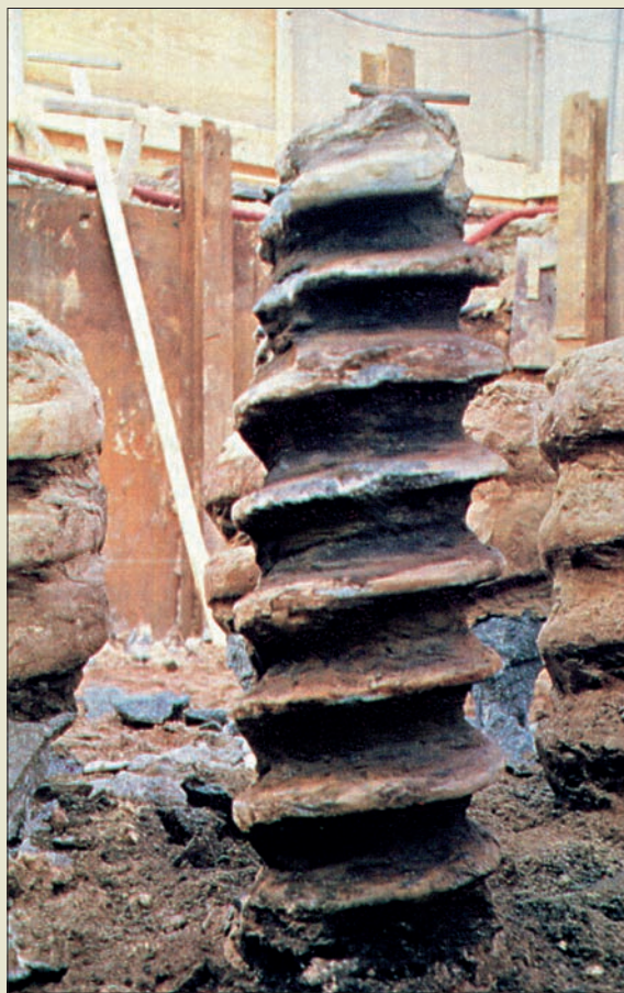
Obr. IV. 58: Tvar obnaženého šroubovitého dříku piloty typu Atlas o průměru 46/56 cm v Německu roku 1987
