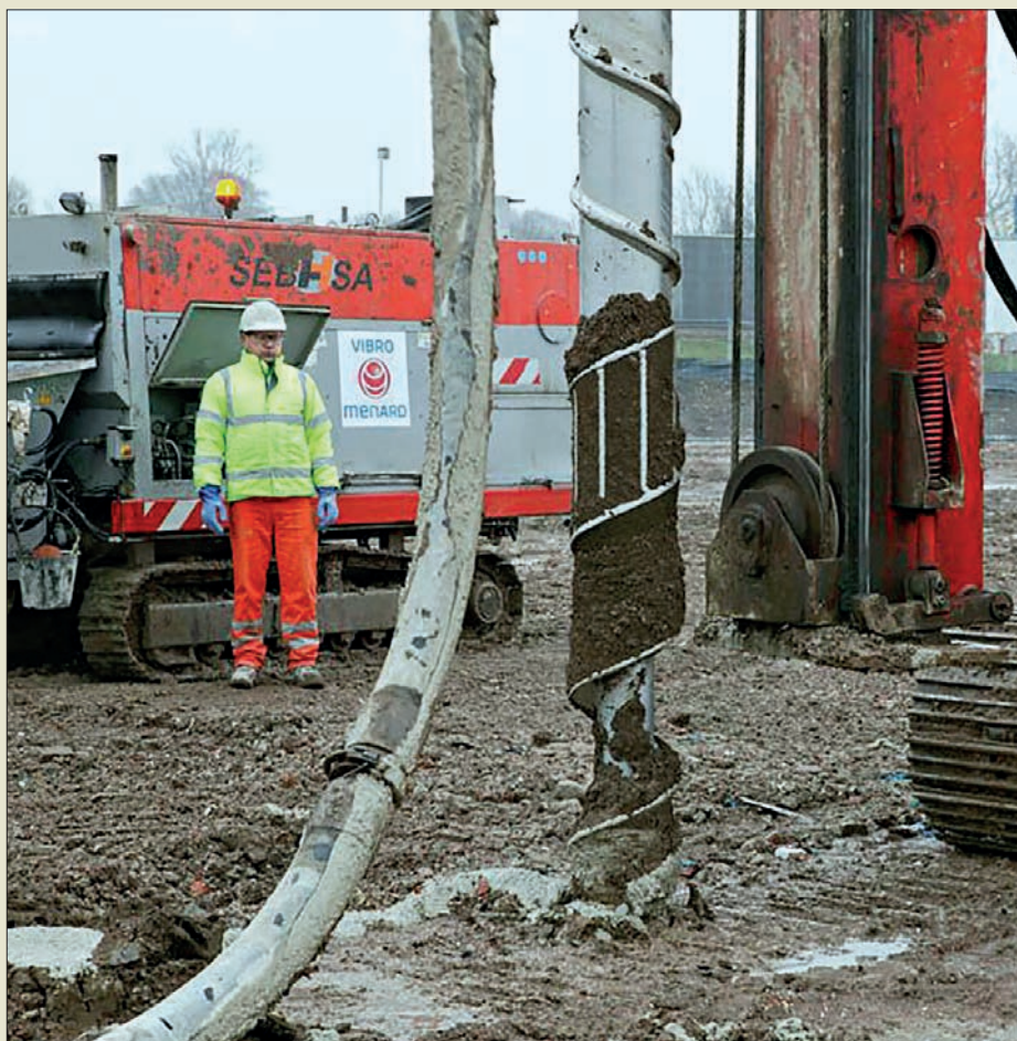
Obr. VI. 71: Typická technologická sestava robustního zařízení firmy Vibro-Menard k provádění sloupových inkluzí CMC z čerpané betonové malty roku 2010
