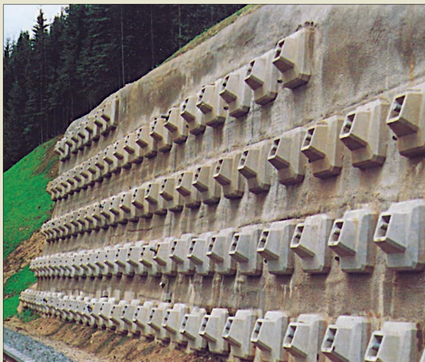
Obr. VI. 91: Typická ukázka zajištění svahu kotvením vybraná z nesmírného počtu podobných staveb realizovaných v závěru 20. století po celém světě s obvyklou účastí úzce specializovaného výrobce kotev a napínací techniky Dywidag
