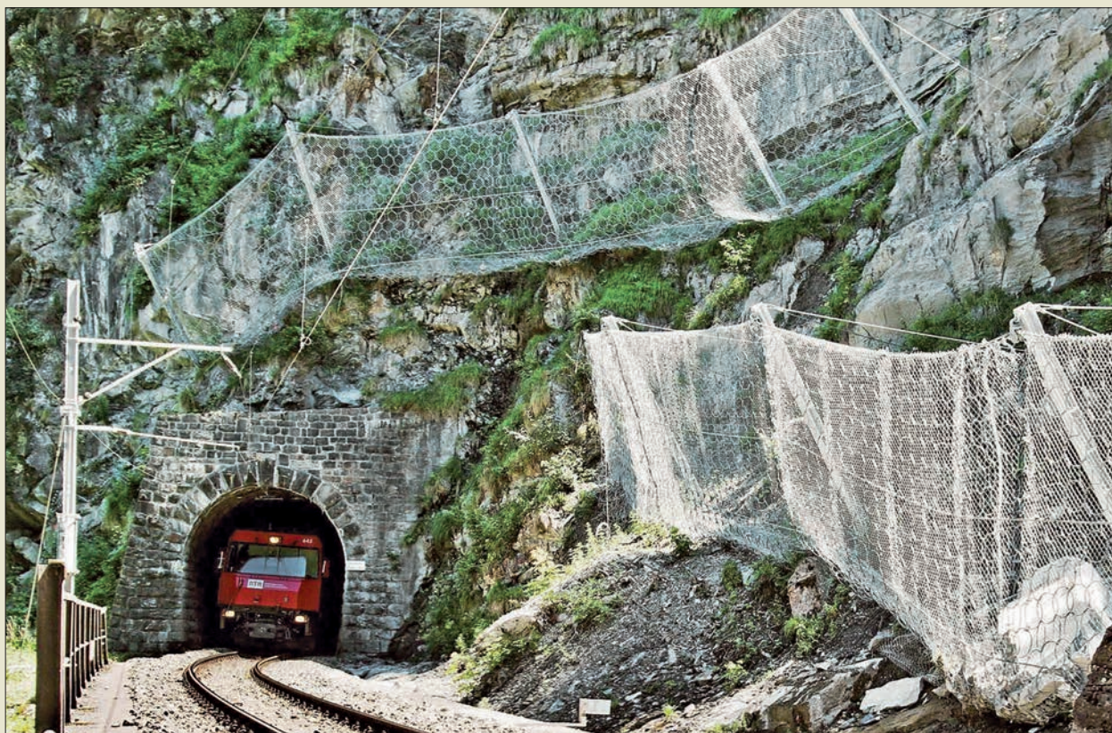
Obr. VI. 105: Záchytný skalní systém RXE-1000 švýcarské firmy Geobrugg zbudovaný roku 2014 na železniční trati u Rumplanas ve Švýcarsku (geobrugg.com)
